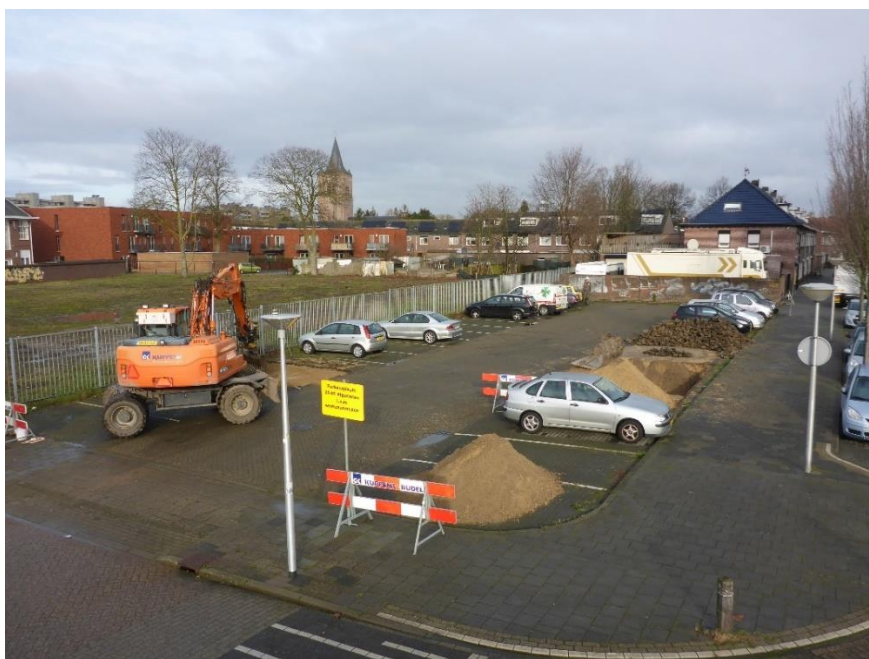
Figuur 5 aanleggen van de proefsleuven
