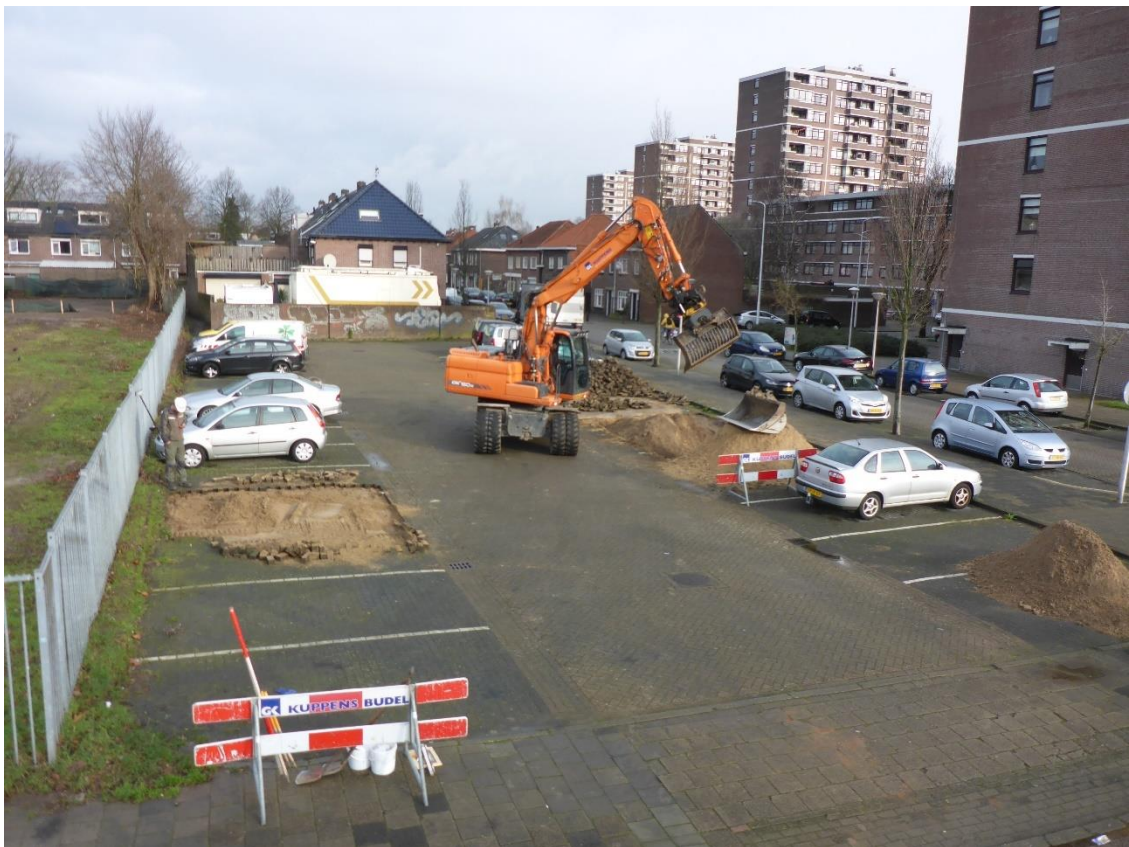
Figuur 9 aanleggen van de proefsleuven
