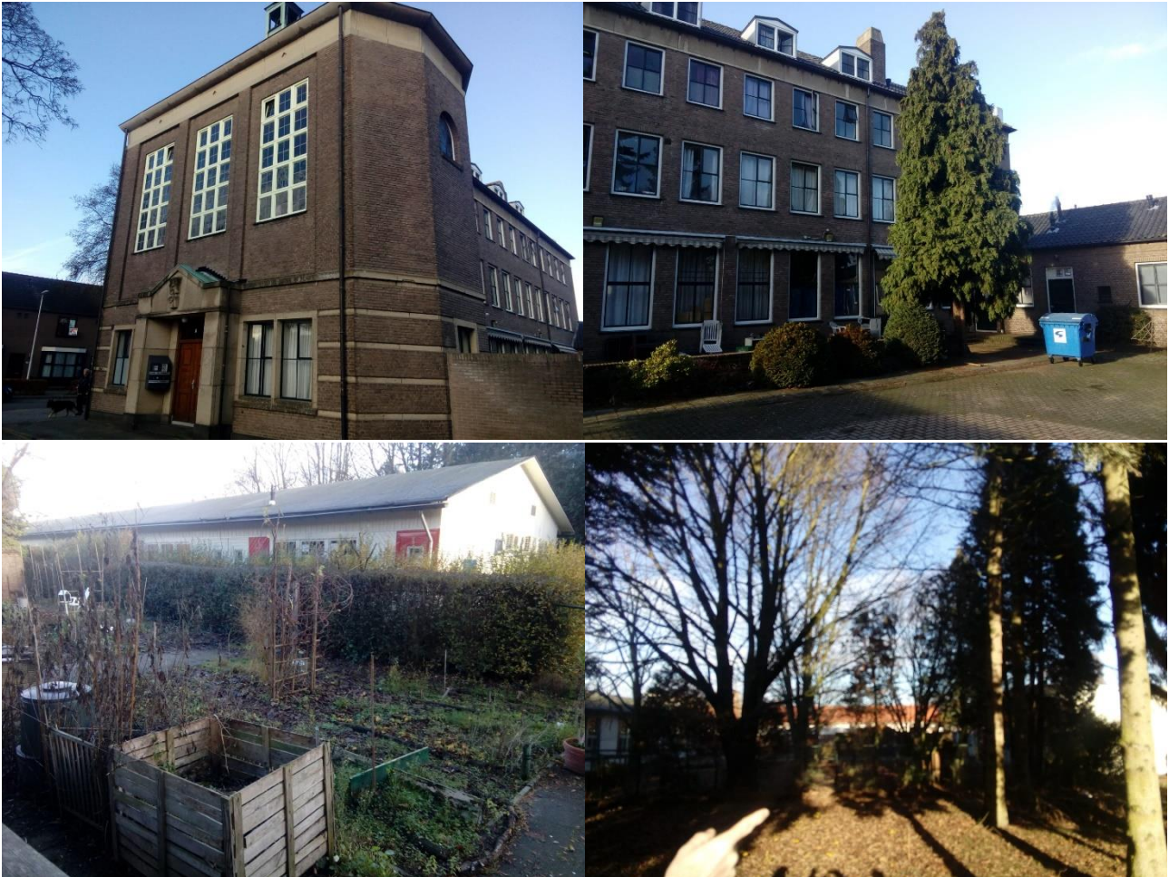
Figuur 2 Linksonder: Zuid- en westgevel voormalig klooster. Rechtsboven: Westgevel voormalig klooster. Linksonder: buurttuin met Finse school op achtergrond. Rechtsonder: Diverse loof- en naaldbomen in het plangebied.
