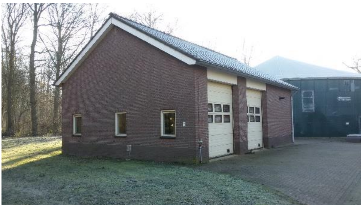
Foto 3: Een ander mogelijk te slopen gebouw. De overhangende pannen aan de zijkant van het gebouw zijn ongeschikt voor gierzwaluwen, huismussen of vleermuizen omwille van te kleine ruimtes en te gladde houtbetimmering. Vleermuizen zouden mogelijk nog kunnen schuilen aan de bovenzijde van de deuren.
