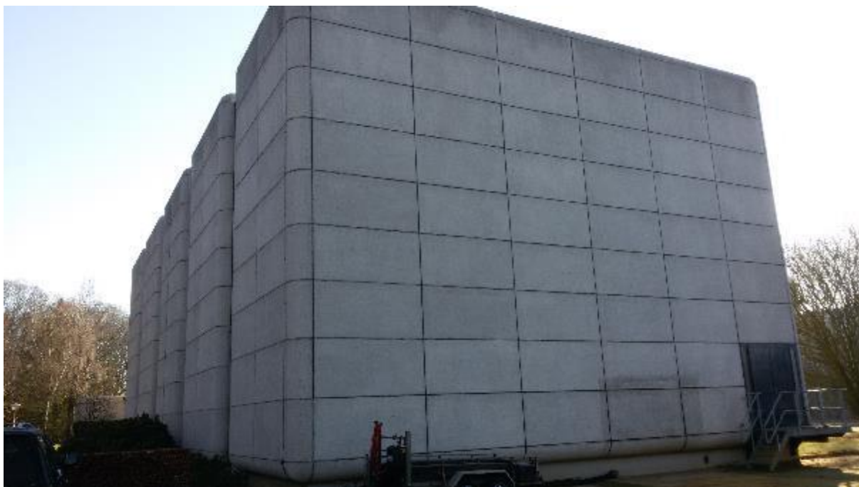
Foto 2: Eén van de gebouwen die mogelijk gesloopt gaan worden.
