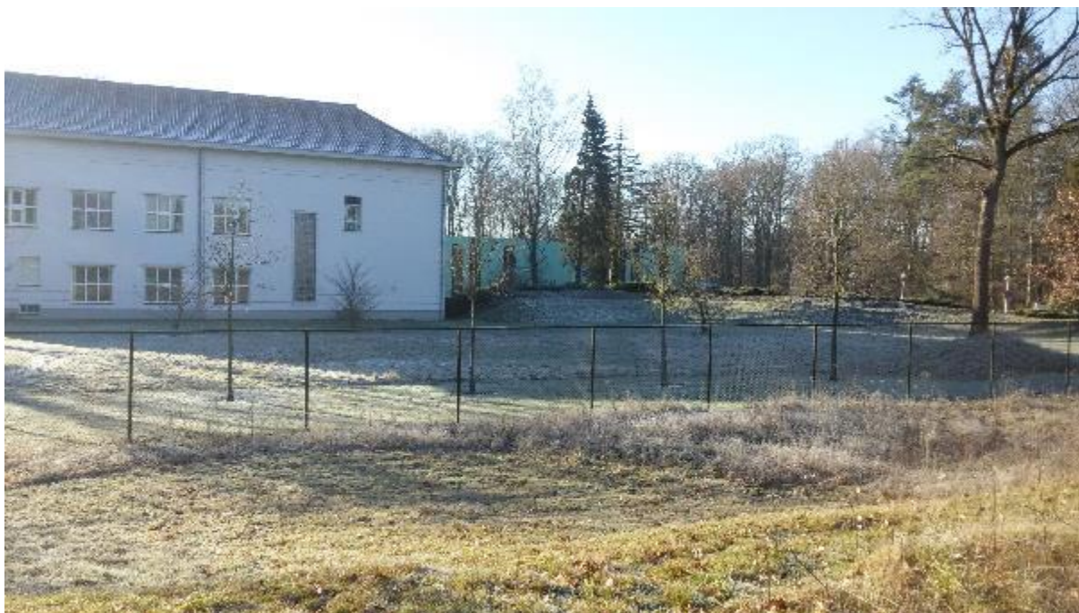
Foto 4: Locatie waar een nieuwe winput wordt aangelegd.
