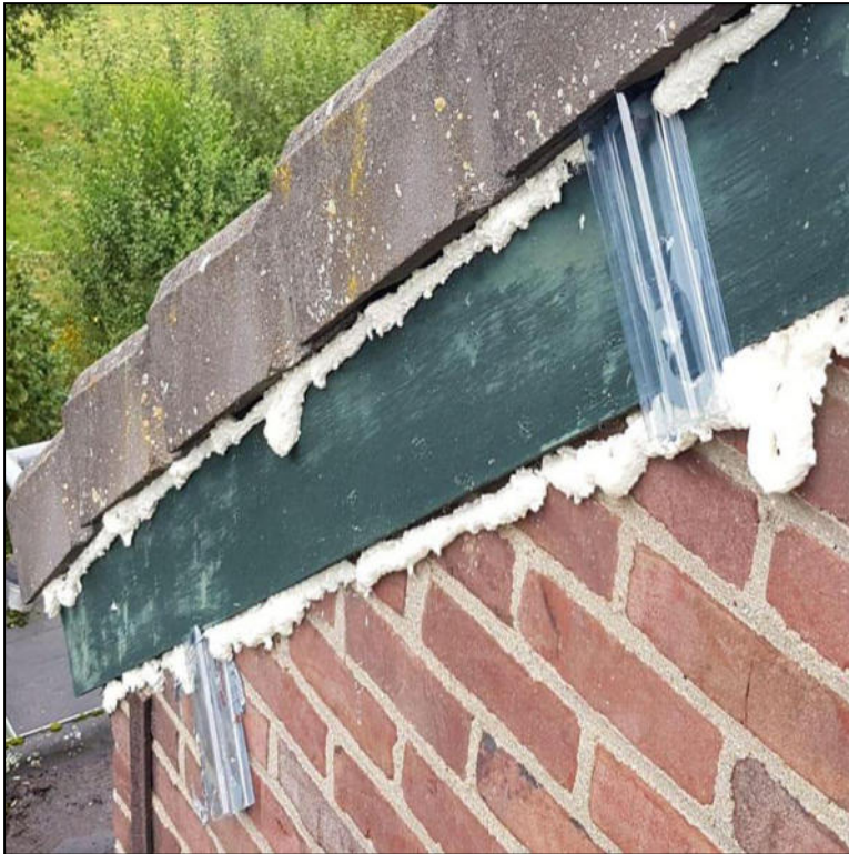
Figuur 6: plastic exclusion flaps als enige uitgang, waarbij de overige openingen zijn dicht gemaakt met polyurethaan (bron: www.faunaprojecten.nl )
