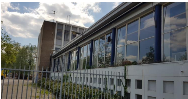
Figuur 4: Kantoorgebouw in zuidoosten plangebied
