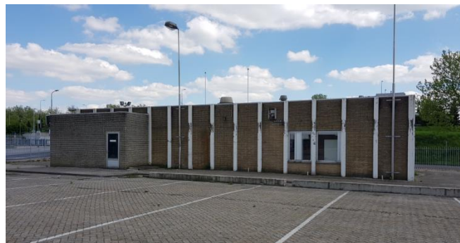
Figuur 5: Bijgebouw in noordoosten plangebied
