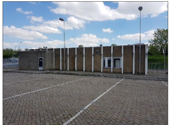
Figuur 6. Bijgebouw in noordoosten plangebied
