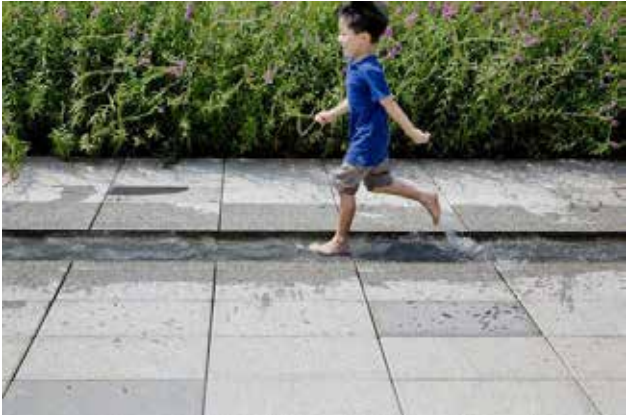
Zichtbare waterafvoer
