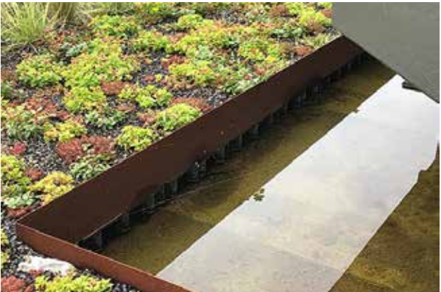
Bufferen op daken (alleen bij nieuwbouw)
