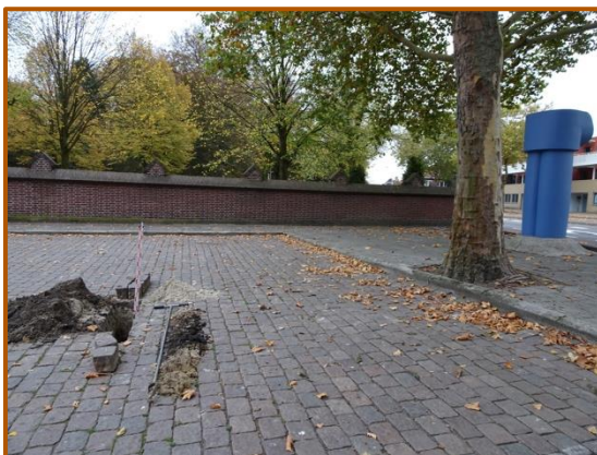
Afbeelding 8: profielkuil 2 ter hoogte van boom 3
