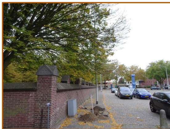
Afbeelding 11: profielkuil 3 ter hoogte van boom 7
