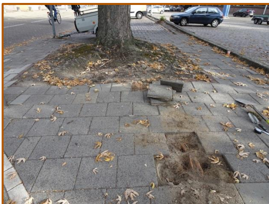
Afbeelding 6: profielkuil 1 ter hoogte van boom 1
