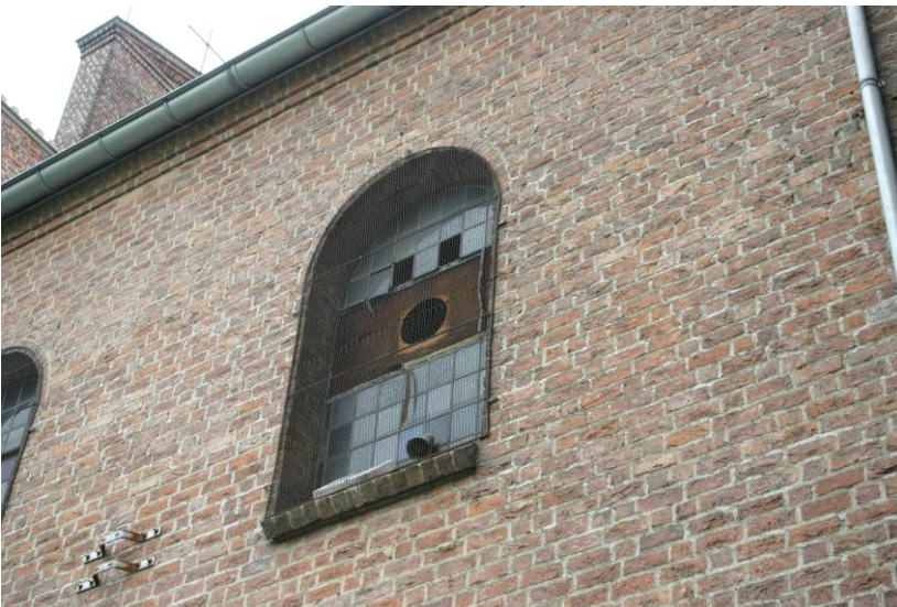
Figuur 4.2.3. De ramen in de Don Boscokerk zijn voorzien van gaas, zodat vleermuizen niet naar binnen kunnen.
