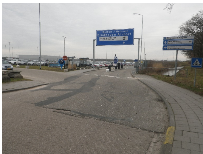
Figuur 2.2 Reparaties Castendijkweg t.h.v. ingang P5
