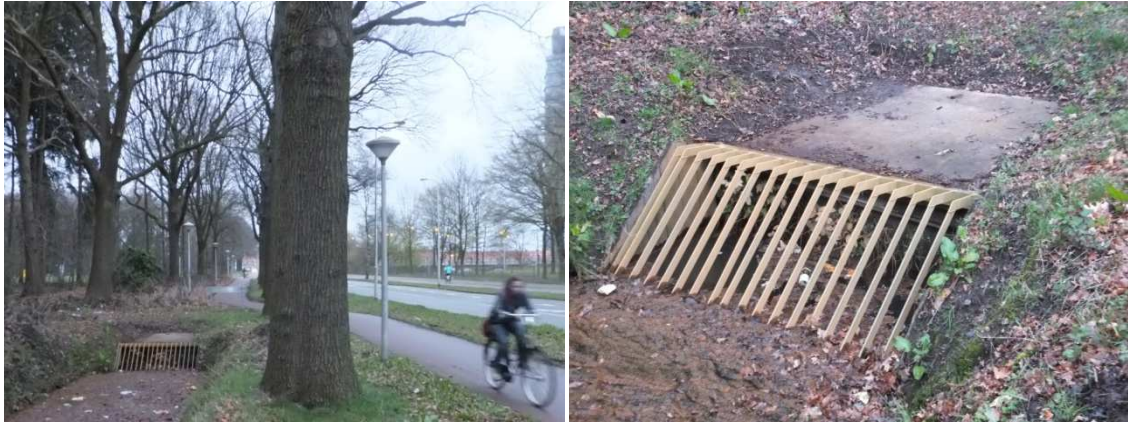
Afbeelding 3.5: Instroompunt duiker ER42-KDU23 naast Vredeoord (foto's Sweco maart 2016)
