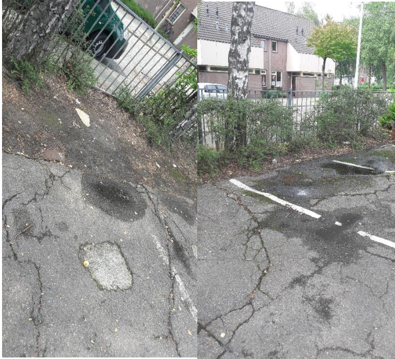
Figuur 5: Asfalt verharding met opdruk
