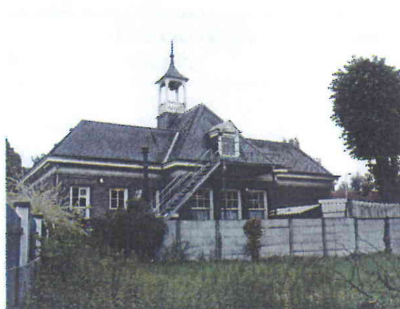
Achterzijde raadhuis met schutting, aanbouw en trappartij
