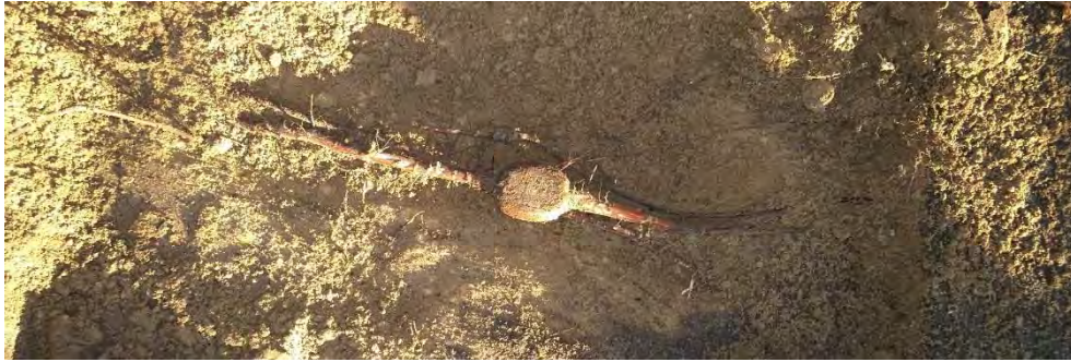
Foto 12. Beworteling bij de opsluitbanden
