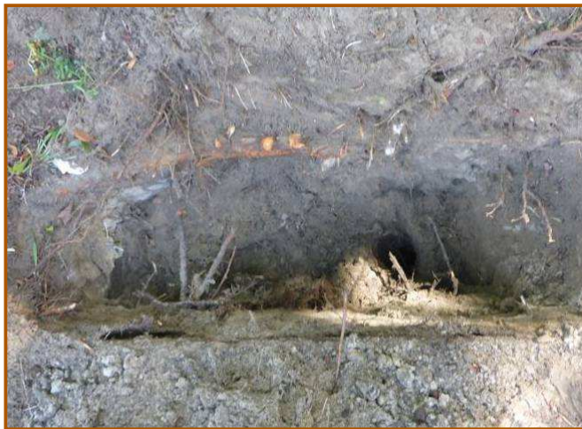
Afbeelding 9. Profielkuil ter hoogte van boom 3
