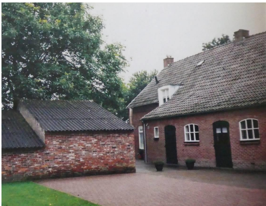
11. Ongedateerde foto. Achtergevel en kippenhokken. Genomen voor de verbouwing van 1998
