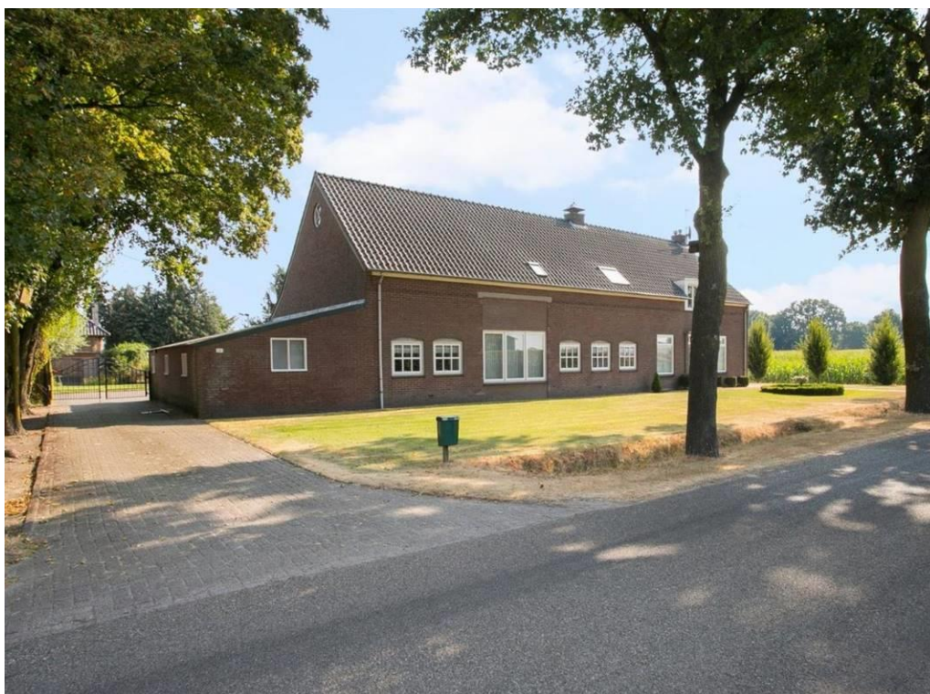
21. Foto 2020. Voorgevel voormalige bedrijfsgedeelte. In de oorspronkelijke gevelopeningen zijn de betonnen stalramen vervangen voor houten exemplaren. De hoge mendeur is in 1998 dichtgemetseld en voorzien van ramen. Aanbouw met lessenaarsdak is oorspronkelijk.
