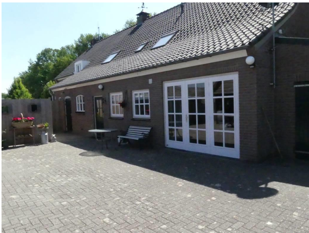
20. Foto 2020. Gevel voormalige bedrijfsgedeelte aan de achterzijde. De gevel rechts met de pui, twee stuks ramen en deur zijn in 1998 vernieuwd. Links in het midden de oorspronkelijke gevel met betonnen stalraam en getoogde deuropening.
