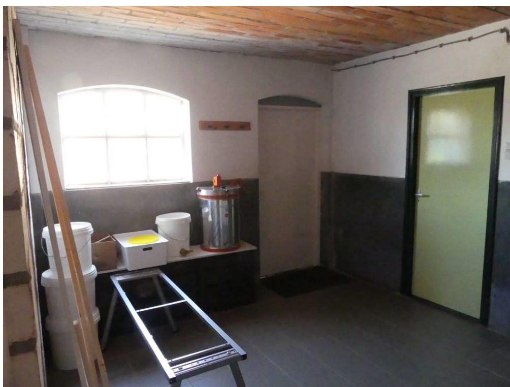
18. Foto 2020. Bijkeuken tussen woongedeelte en voormalig bedrijfsgedeelte. Rechts oorspronkelijke binnendeur naar portaal aan de achterzijde. Links het oude betonnen stalraam. Verdiepingsvloer uit holle bouwstenen.
