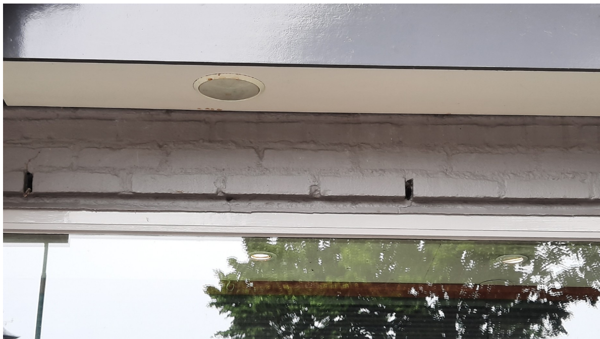
Voor vleermuizen geschikte invliegopeningen in het plangebied. (Foto: M.M. Bouwmeester| Ecoresult B.V.).
