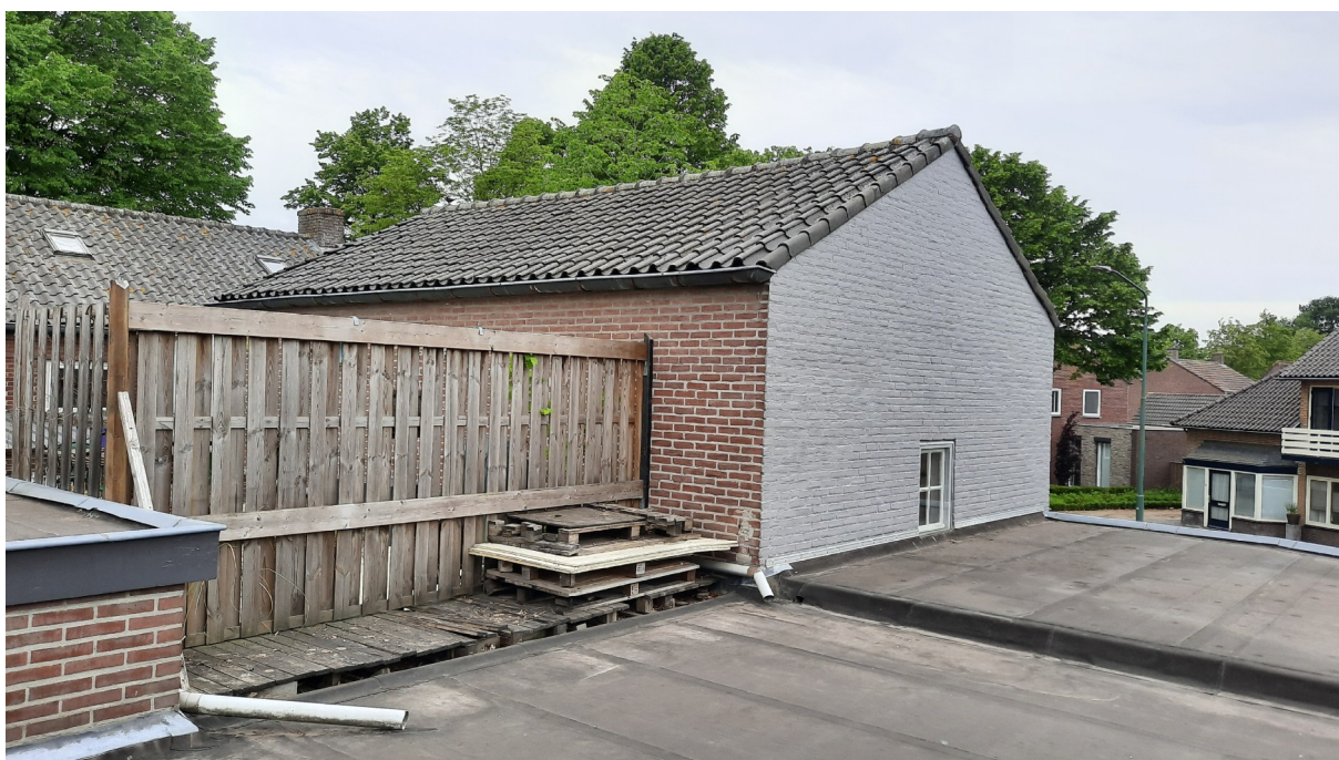
De ruimte onder de pannendaken is geschikt als vaste rust- en verblijfplaats van huismus, gierzwaluw en diverse vleermuissoorten. (M.M. Bouwmeester | Ecoresult B.V.).
