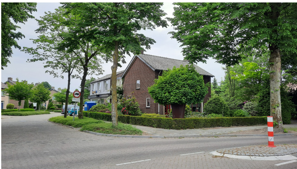
Het plangebied gezien vanaf de kruising van Kloosterstraat en Willibrordusstraat (M.M. Bouwmeester | Ecoresult B.V.).
