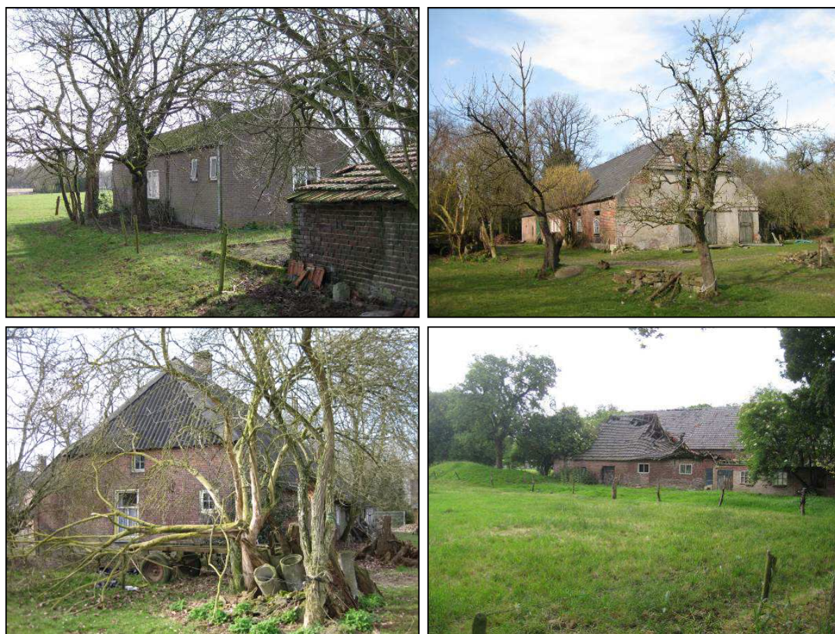
Figuur 5: Foto's bebouwing Postels Huufke 2-4 (deel 1)
