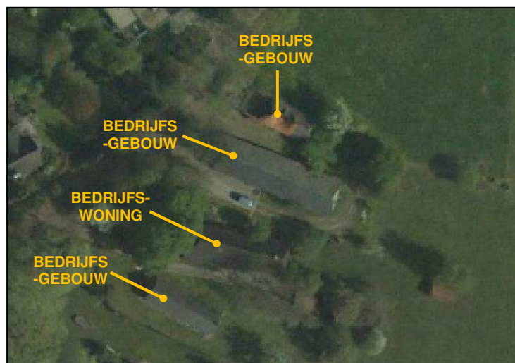
Figuur 4: Overzicht bebouwing Postels Huufke 2-4
