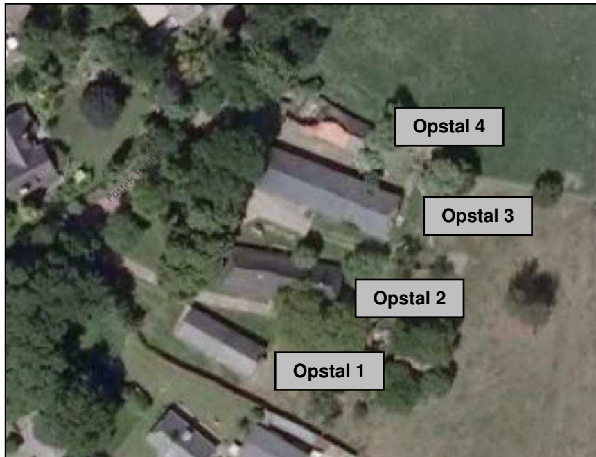
Figuur 41: Overzicht bebouwing Postels Huufke
