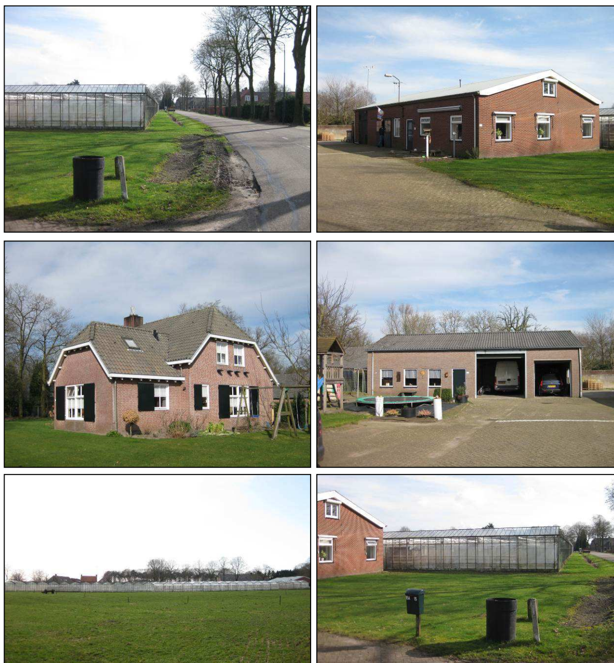
Figuur 8: Foto's bedrijfsbebouwing Mr. de la Courtstraat 15
