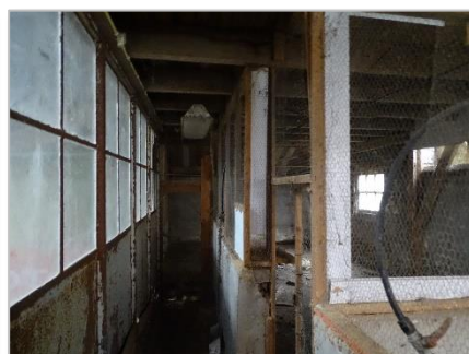
Foto 59: Schuur 2: lage stal met ruimtes voormalige houderij hobbydieren (pluimvee).
