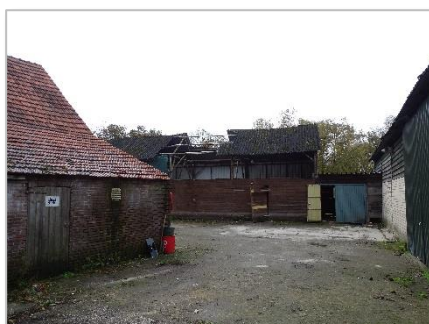
Foto 53: Verharding tussen Schuur 2 (rechts), Schuur 3 (links) en Schuur 1 (recht tegenover).
