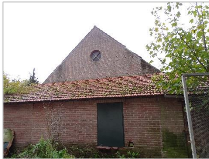
Foto 98: Schuur 3: met aanbouw.
