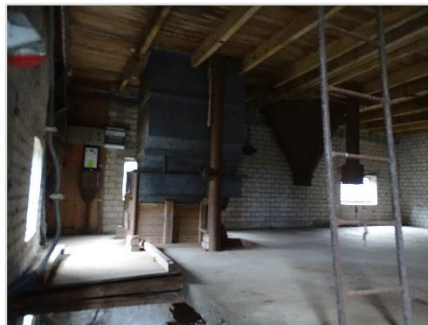
Foto 113: Schuur 3: interieur (schoon en opgeruimd).
