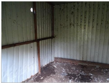
Foto 16: Interieur Opstal 1 (opgeruimd en schoon).
