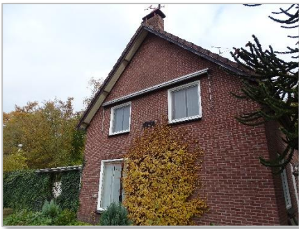
Foto 37: Woning (blijft behouden).
