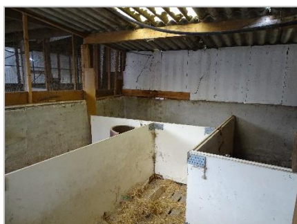
Foto 58: Schuur 2: lage stal met ruimtes voormalige houderij hobbydieren (pluimvee).
