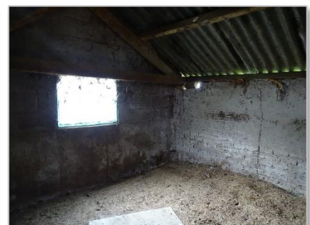
Foto 72: Schuur 2: interieur hoge stal (schoon en opgeruimd) - openingen muur/dakrand.
