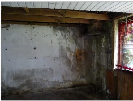
Foto 109: Schuur 3: interieur (schoon en opgeruimd).
