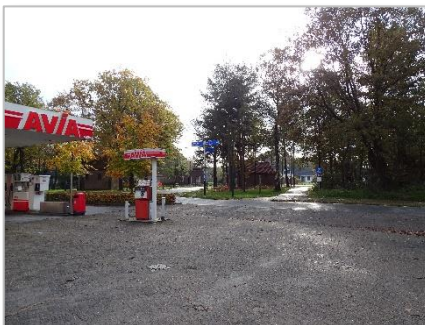
Foto 34: Tankstation met omliggende verharding (zicht op kruising Vessemseweg/Eerselseweg).
