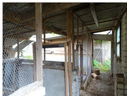
Foto 56: Schuur 2: lage stal met ruimtes voormalige houderij hobbydieren (pluimvee).
