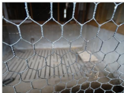
Foto 57: Schuur 2: lage stal met ruimtes voormalige houderij hobbydieren (pluimvee).
