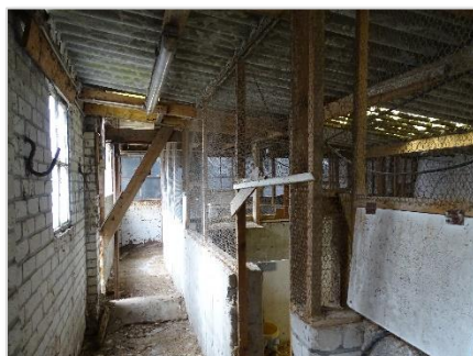
Foto 55: Schuur 2: lage stal met ruimtes voormalige houderij hobbydieren (pluimvee).
