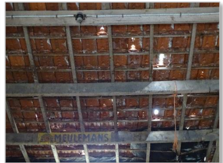
Foto 99: Schuur 3: geen betimmering onder dakpannen/geen verblijfplaatsen vleermuizen.
