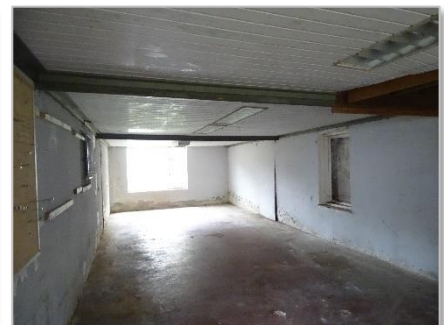
Foto 108: Schuur 3: interieur (schoon en opgeruimd).
