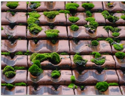
Foto 97: Schuur 3: aansluitende dakpannen.
