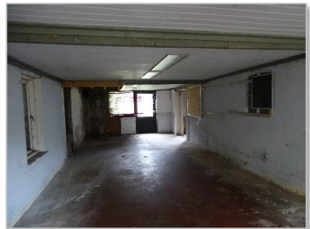
Foto 111: Schuur 3: interieur (schoon en opgeruimd).
