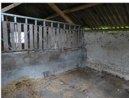
Foto 70: Schuur 2: interieur hoge stal (schoon en opgeruimd) - openingen muur/dakrand.
