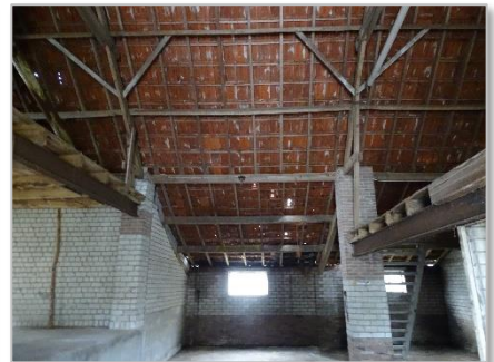
Foto 102: Schuur 3: geen betimmering onder dakpannen/geen verblijfplaatsen vleermuizen.
