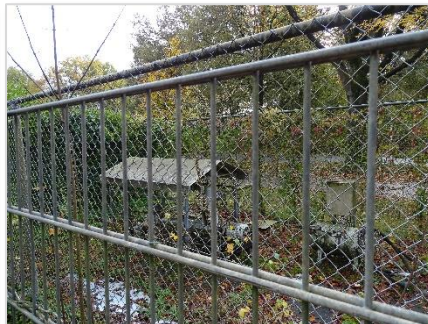
Foto 29: Impressie Veld 4: afgesloten deel met voorraadtanks Tankstation.
