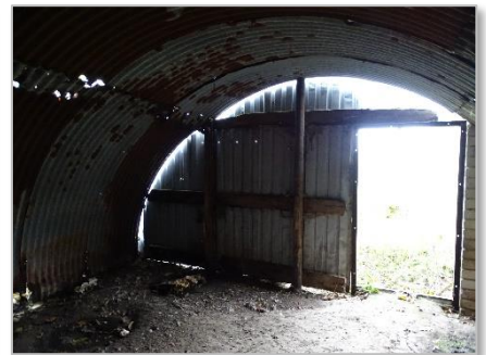
Foto 18: Interieur Opstal 1 (opgeruimd en schoon).
