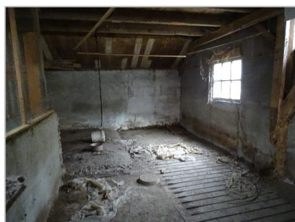
Foto 60: Schuur 2: lage stal met ruimtes voormalige houderij hobbydieren (pluimvee).
