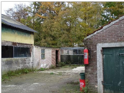
Foto 49: Verharding tussen Schuur 2 (links) en Schuur 3 (rechts).
