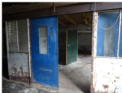
Foto 107: Schuur 3: interieur (schoon en opgeruimd).
