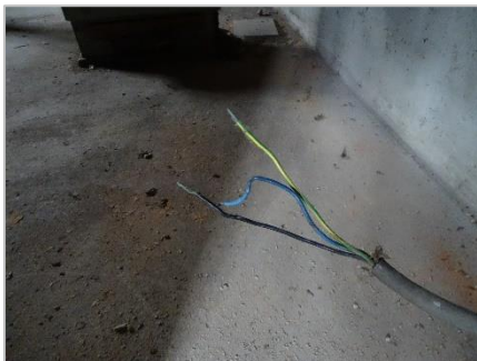
Foto 112: Schuur 3: interieur (schoon en opgeruimd).
