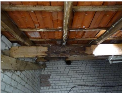
Foto 100: Schuur 3: geen betimmering onder dakpannen/geen verblijfplaatsen vleermuizen.
