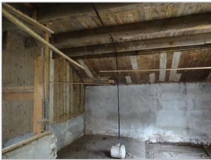
Foto 61: Schuur 2: lage stal met ruimtes voormalige houderij hobbydieren (pluimvee).
