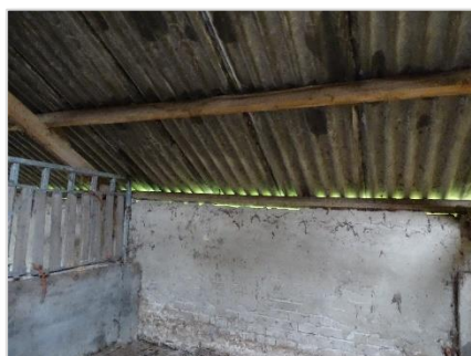
Foto 71: Schuur 2: interieur hoge stal (schoon en opgeruimd) - openingen muur/dakrand.
