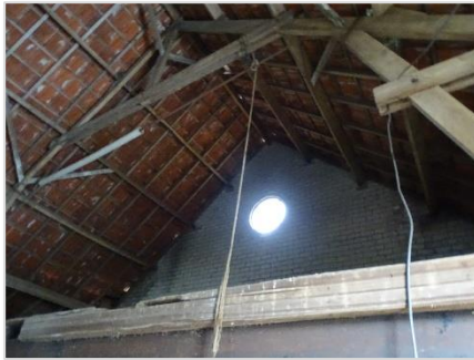
Foto 101: Schuur 3: geen betimmering onder dakpannen/geen verblijfplaatsen vleermuizen.
