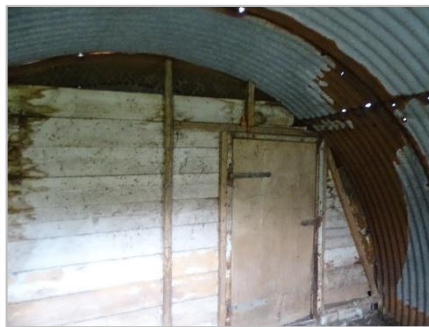
Foto 17: Interieur Opstal 1 (opgeruimd en schoon).
