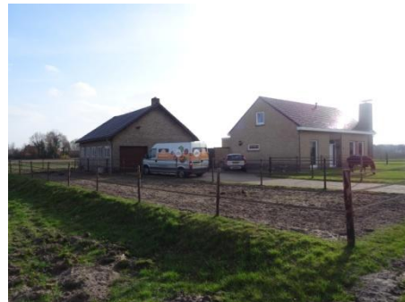
Bestaande woning aan de noordzijde van het plangebied
