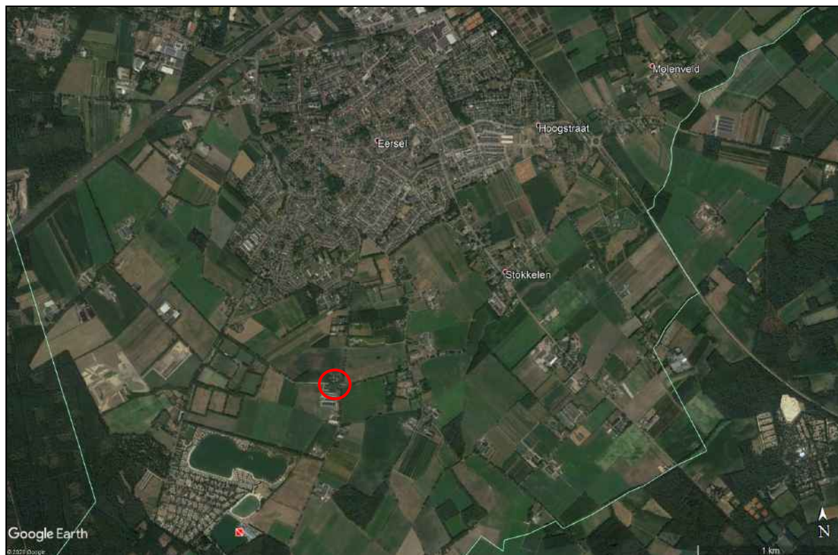
Figuur 2: luchtfoto van de omgeving van het plangebied (rood omcirkeld) (bron: Google Earth)
