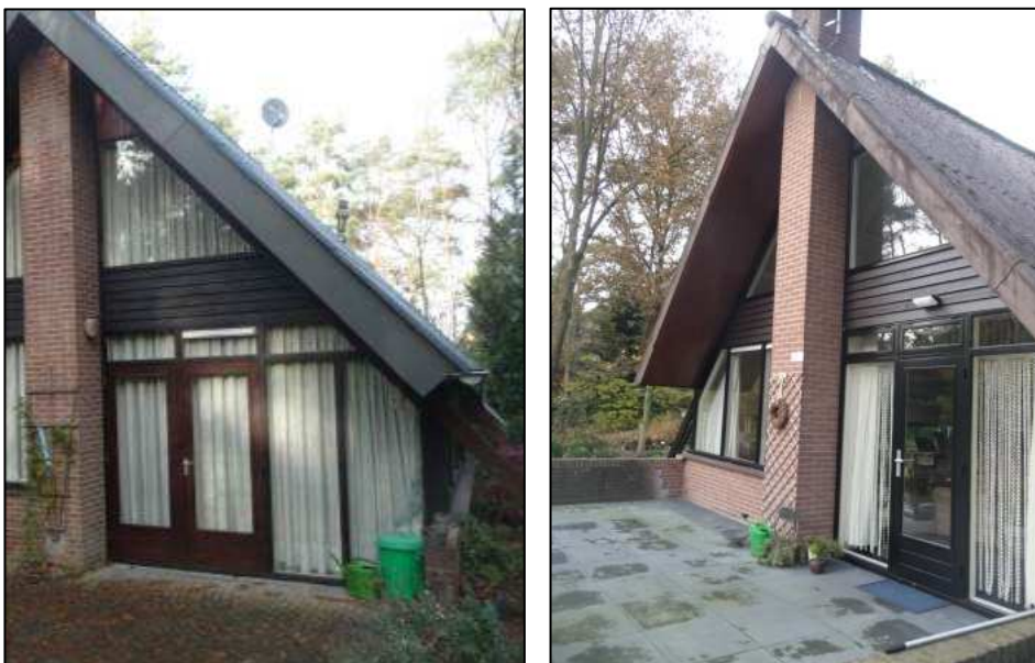
Figuur 10: Voorbeeld tuindeur vervangen door kozijn
