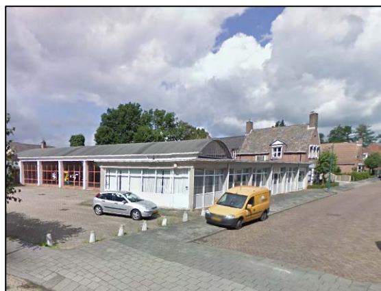
Aanzicht van het in het plangebied aanwezige bedrijfspand. Het bouwvolume bestaat uit één bouwlaag, gedeeltelijk met een gebogen dak en gedeeltelijk met plat dak. Rechts de Stoomberg.
