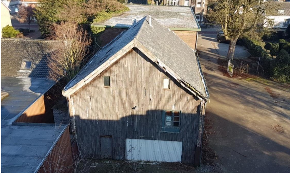
Foto 5. Dak, noord- en oostgevel gebouw 4
