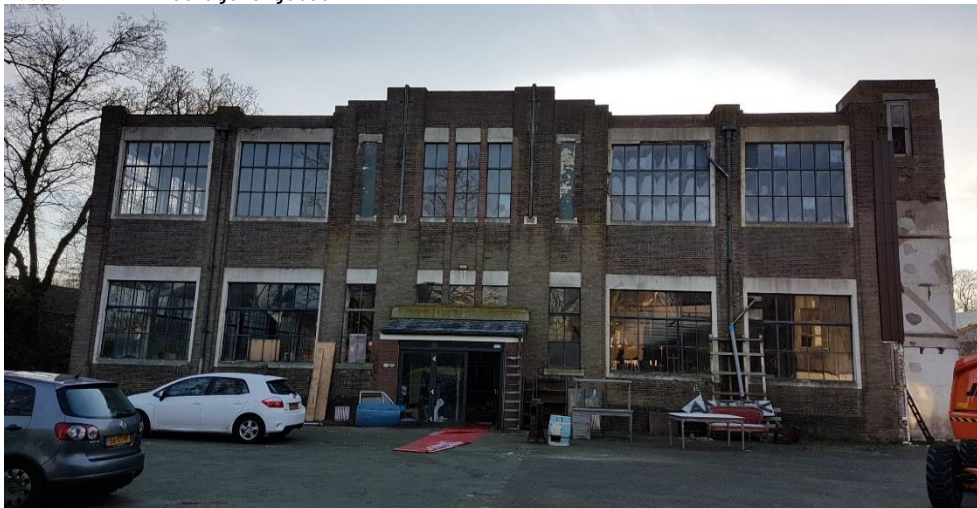
Foto 2. Dak en westgevel gebouw 1
