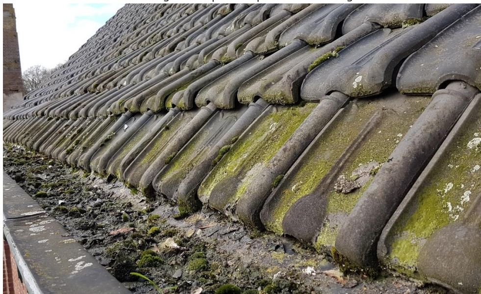
Foto 1. Strakke aansluiting van dakpannen op dakbeschot van gebouw 2
