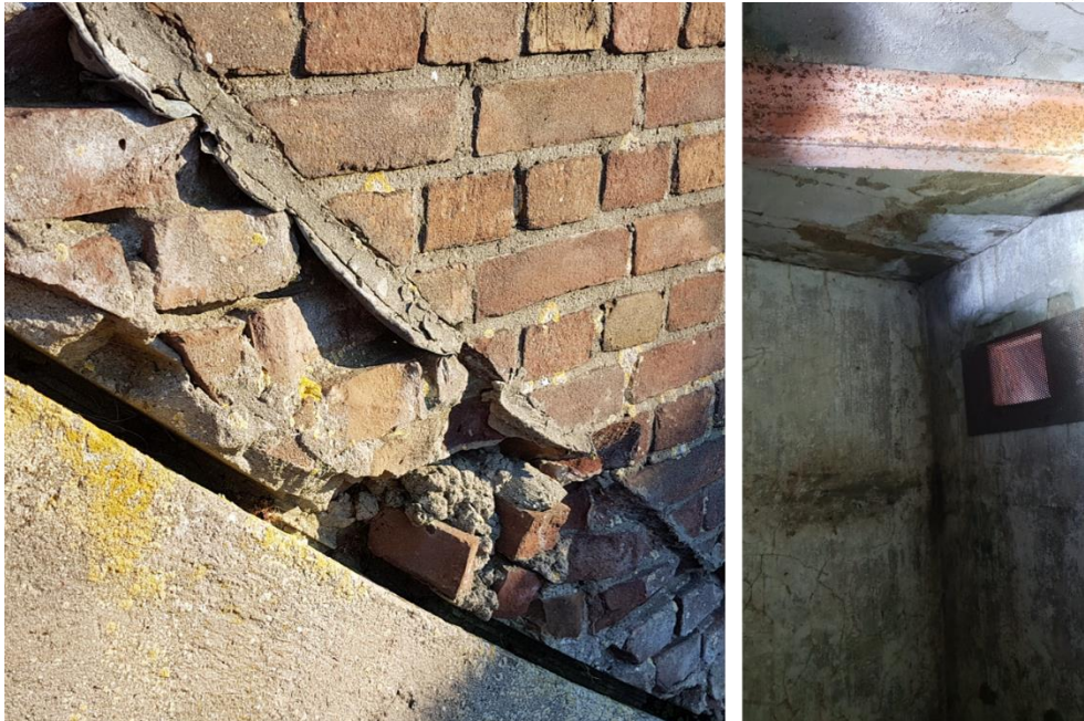
Foto 2. Kieren in de liftschacht (foto links) en open ruimte tussen lift en schacht (foto rechts)
