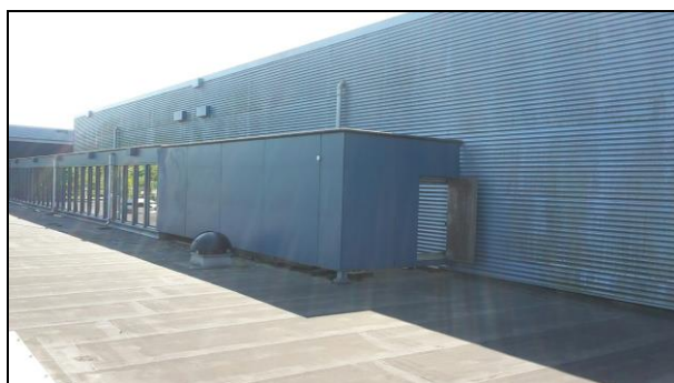
Foto 01 Dakopbouw vide + afscherming luchtbehandeling
