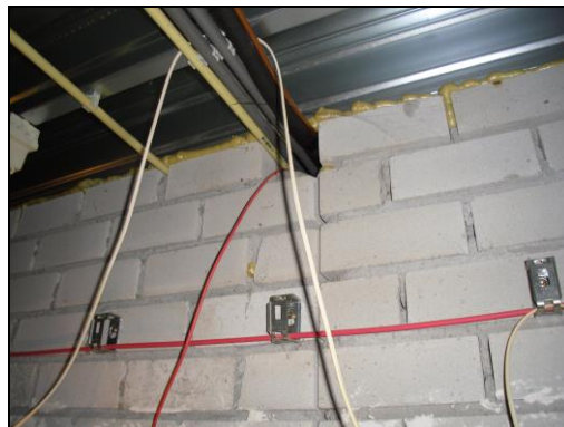
Foto 16 doorvoeren in binnenmuur
