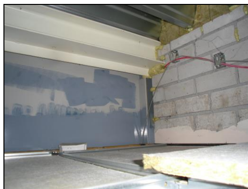
Foto 14 paneelafwerking binnenzijde buitendeur feestzaal
