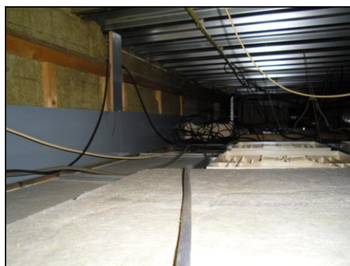
Foto 24 plenumruimte boven systeemplafond
