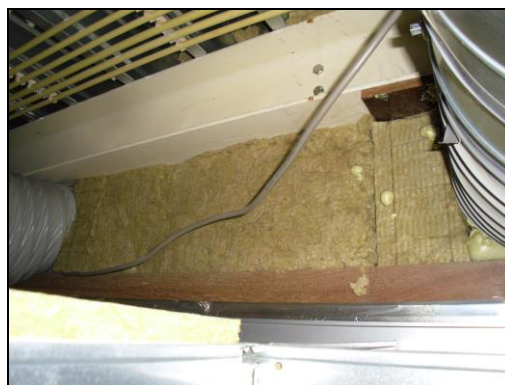
Foto 08 afdichting boven paneelwand sportcafé
