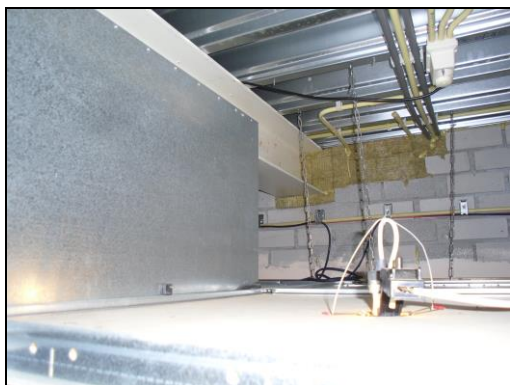
Foto 13 afdichting bij binnenmuur gang
