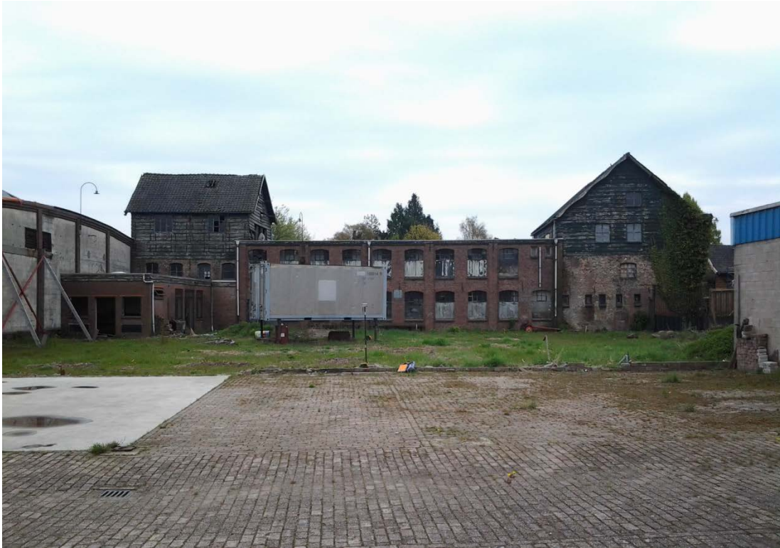
Afbeelding 2.14 Foto genomen vanaf de locatie waar het appartement gebouwd zal worden en boring 1 werd gezet, in zuidoostelijke richting, met zicht op de voormalige leerlooierij.
