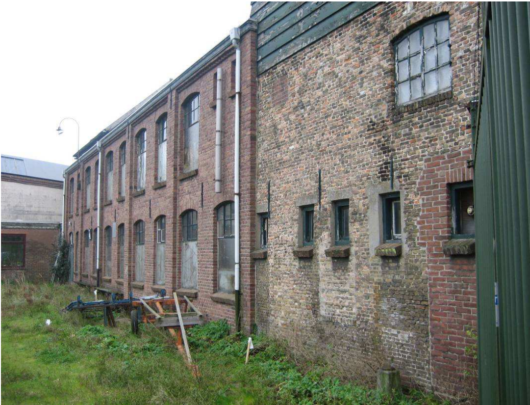
Foto C15-16 De looierij van Cloin met hierachter de schoenfabriek. Het metselwerk dateert mogelijk nog van een huisleerlooielij. Twee dichtgemetselde raampjes op de begane grond van het looierijgedeelte van de huisleerlooielij zijn nog zichtbaar. Onder is de langsgewel van dezelfde looierij zichtbaar omstreeks 1930. Ook hier valt het metselwerk uit verschillende periodes op en een kozijn met luiken dat mogelijk van het woongedeelte van de huisleerlooielij is. (foto archief Heemkundekring De Heerlyckheit Dongen)
