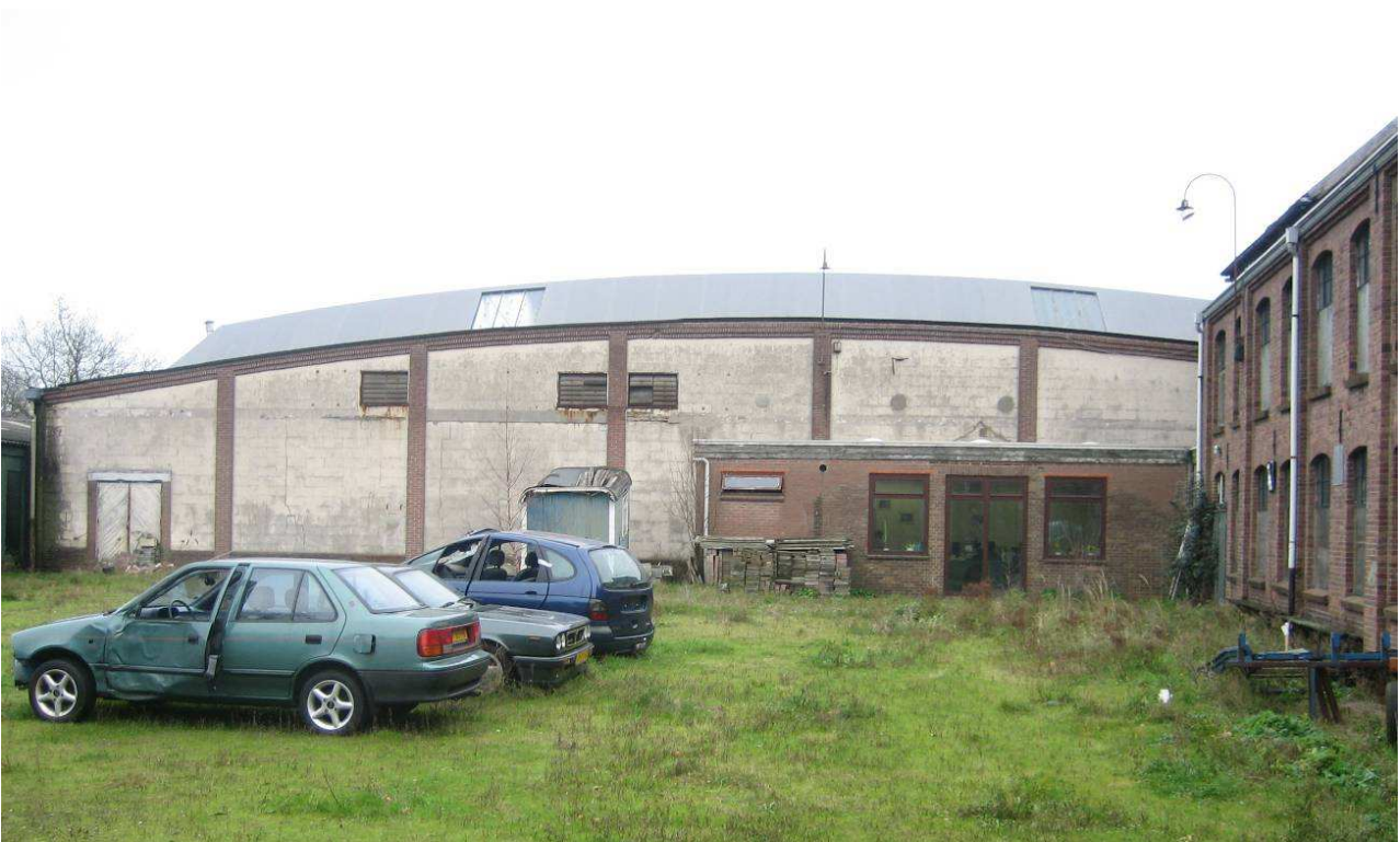
Foto C27-28 De Pannekoekhal in zijn huidige toestand. Het betonskelet is goed zichtbaar. (foto Kees Boas)
