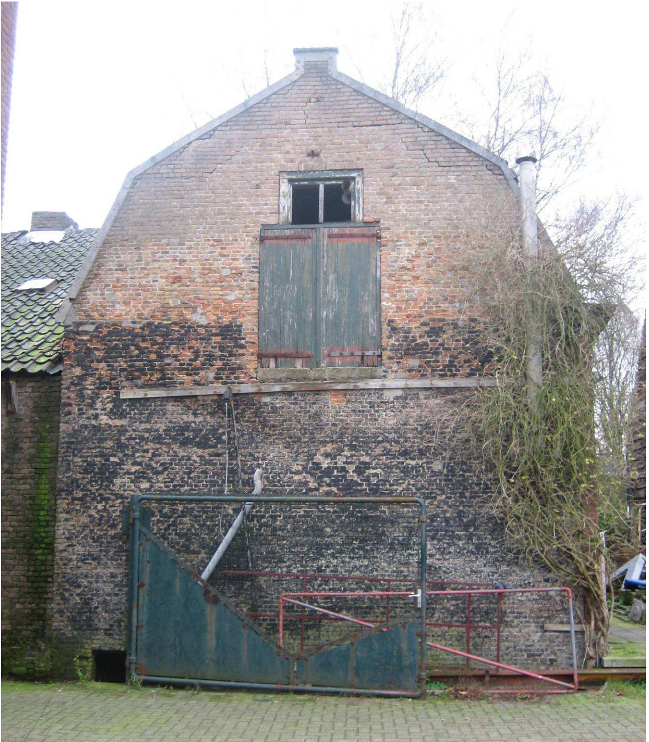
Foto C1 Gedeelte van de gevel van een mogelijk 17 e eeuwse boerderij “hergebruikt” in twee woninkjes met een werkplaats van omstreeks 1900. Let op het kelderraampje van de eveneens nog aanwezige kelder links onder in de gevel. (foto Kees Boas)
