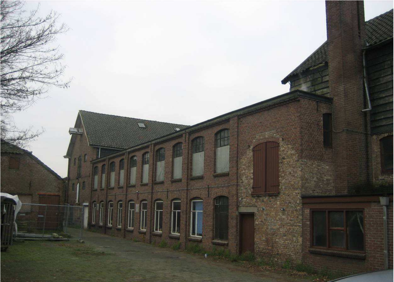
Foto C18-19 Foto van de schoenfabriek uit omstreeks 1924 ingeklemd tussen de twee traditionele looierijen. Kenmerkend is het strenge gevelritme 5, stalen kozijnen en siermetselwerk aan de dakrand en schoorsteen. (foto Kees Boas)
