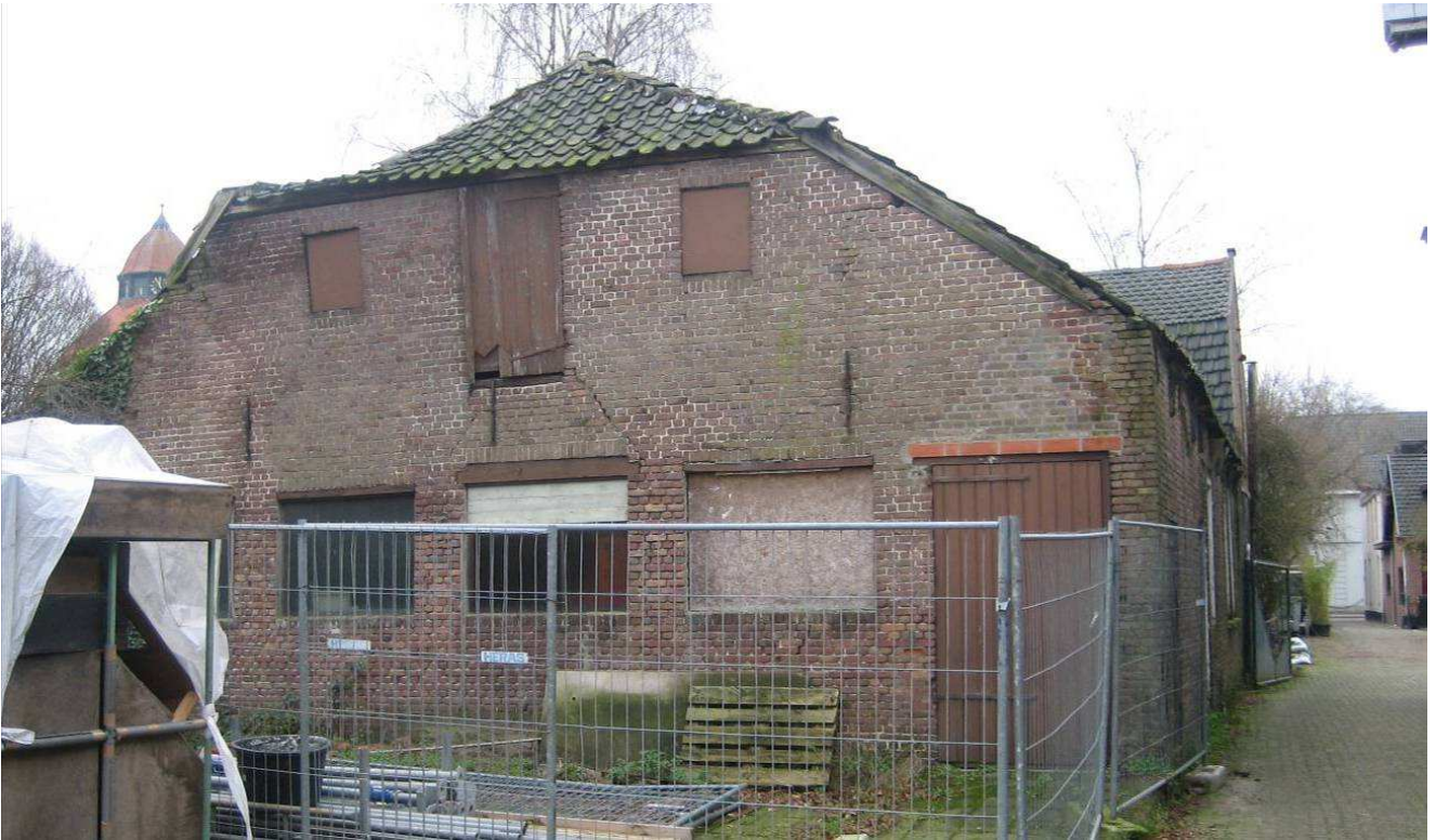
Foto 10 Achterzijde van de werkplaats van aannemer Schellekens. Op de foto is het luik naar de houtopslagzolder boven de werkplaats goed zichtbaar. (foto Kees Boas)
