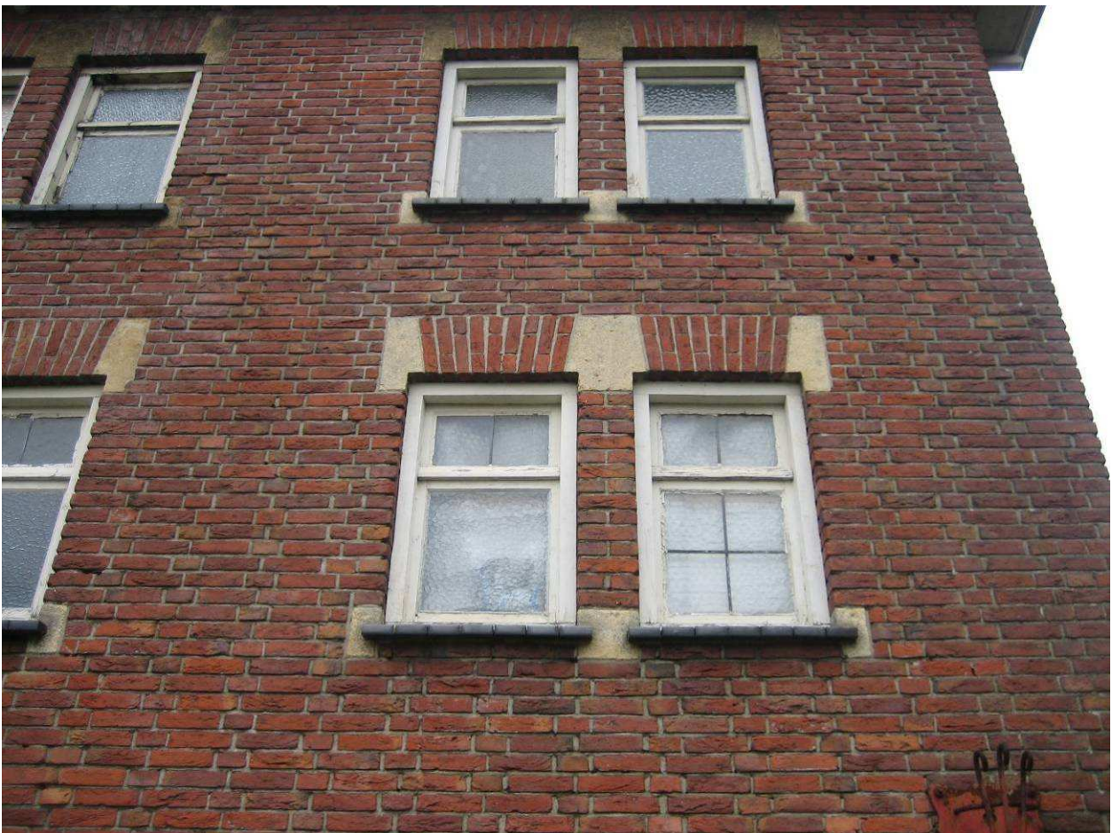
Foto C20-21 De kantoorgevel in Traditionele Delftse Schoolstijl. Zorgvuldig gedetailleerde vensters met natuurstenen aanzetstenen . Onder in beeld een rijk gedetailleerde vlaggenmasthouder. (foto Kees Boas)
