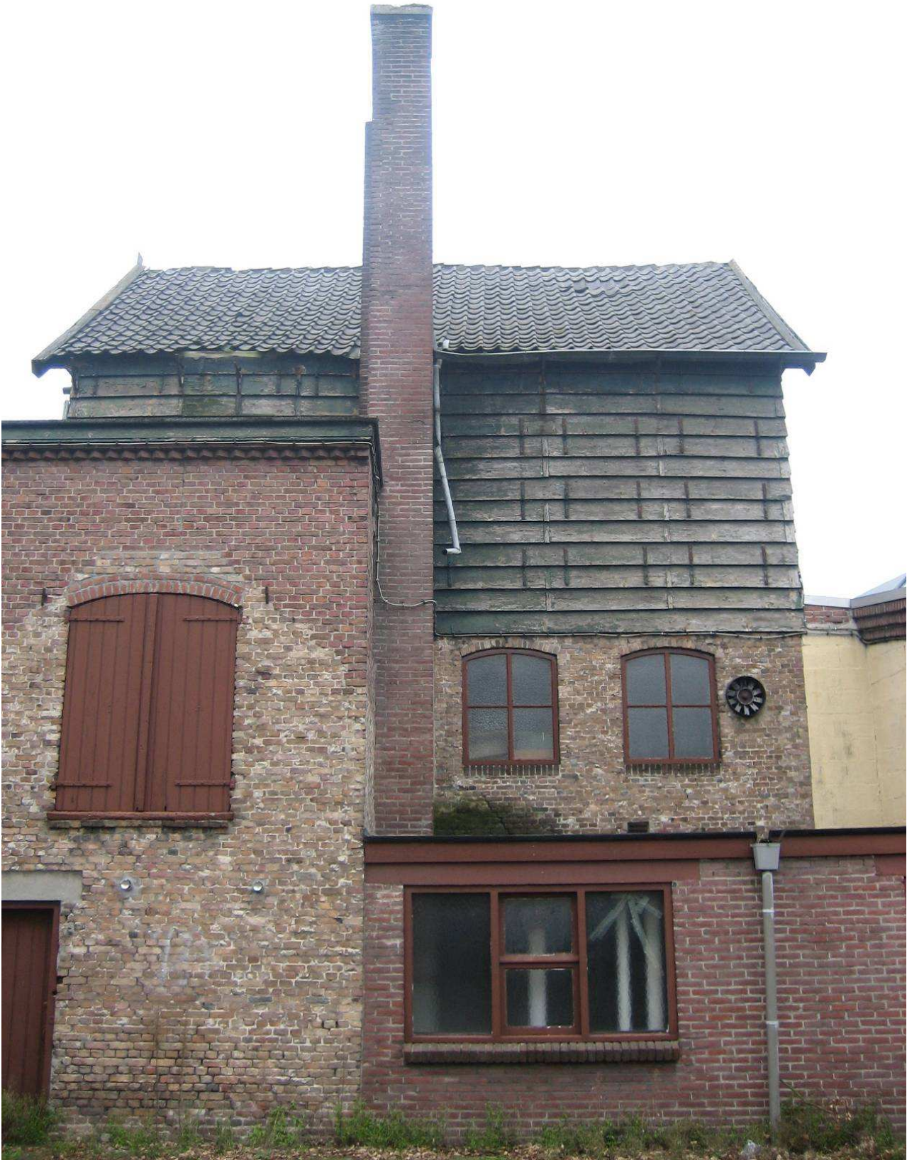
Foto C17 Foto van de tweede traditionele looierij langs de sticht. Opvallend zijn de droogluiken aan alle vier de zijden van het bouwwerk en de aanbouw met transportluiken. Goed zichtbaar is de oude daklijn van het aanbouwtje opgenomen in het metselwerk van de vooroorlogse schoenfabriek. (foto Kees Boas)
