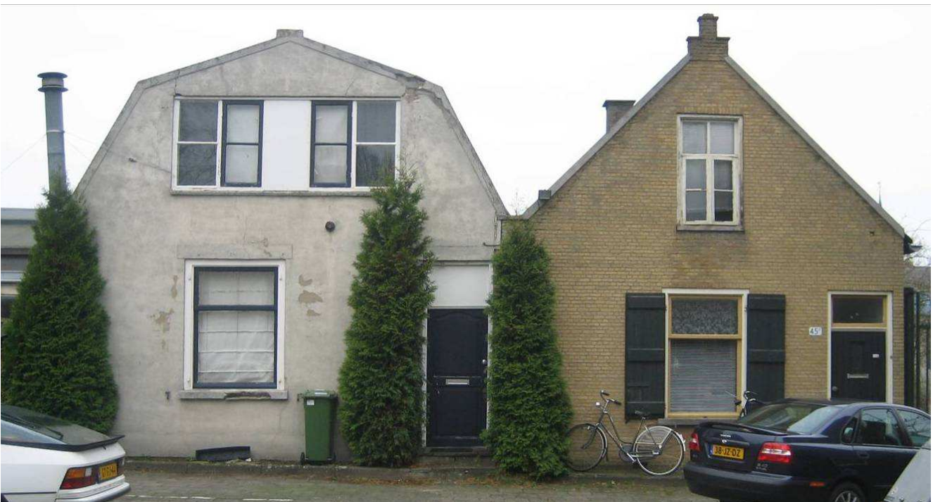
Foto C11 De twee 19 e eeuwse arbeiderswoningen. De linkse woning heeft in de loop der tijd een mansardekap gekregen. Deze kapconstructie leverde optimale woonruimte op voor kleine woninkjes zoals deze en werd daarom veelvuldig toegepast. De rechter woning heeft nog een inmiddels zeldzame traditionele gevelbekroning zoals die in de dongen in 17 e , 18 e en 19 e eeuw veelvuldig werd toegepast. (foto Kees Boas)
