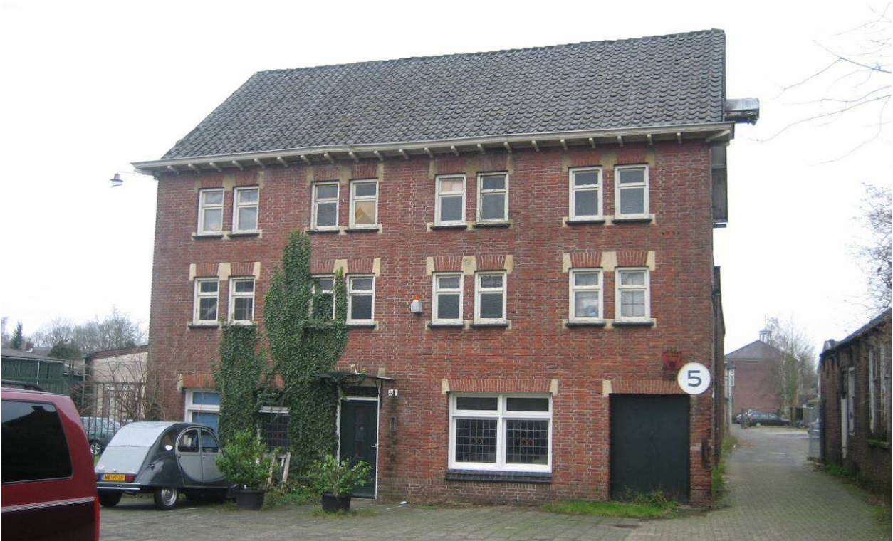
Foto C20-21 De kantoorgevel in Traditionele Delftse Schoolstijl. Zorgvuldig gedetailleerde vensters met natuurstenen aanzetstenen . Onder in beeld een rijk gedetailleerde vlaggenmasthouder. (foto Kees Boas)
