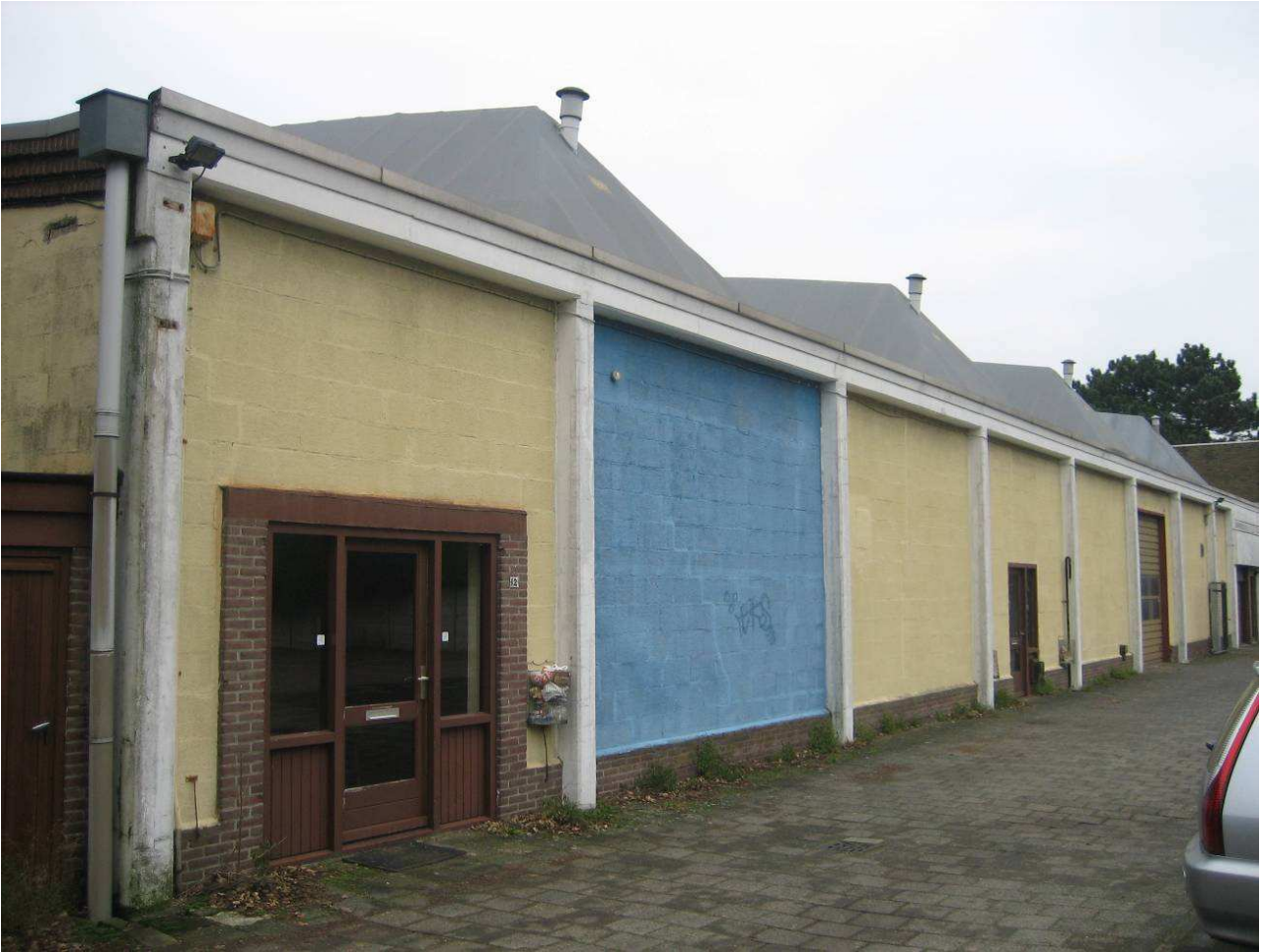
Foto C27-28 De Pannekoekhal in zijn huidige toestand. Het betonskelet is goed zichtbaar. (foto Kees Boas)
