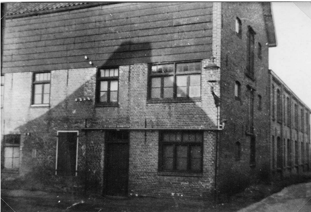
Foto C15-16 De looierij van Cloin met hierachter de schoenfabriek. Het metselwerk dateert mogelijk nog van een huisleerlooielij. Twee dichtgemetselde raampjes op de begane grond van het looierijgedeelte van de huisleerlooielij zijn nog zichtbaar. Onder is de langsgewel van dezelfde looierij zichtbaar omstreeks 1930. Ook hier valt het metselwerk uit verschillende periodes op en een kozijn met luiken dat mogelijk van het woongedeelte van de huisleerlooielij is. (foto archief Heemkundekring De Heerlyckheit Dongen)
