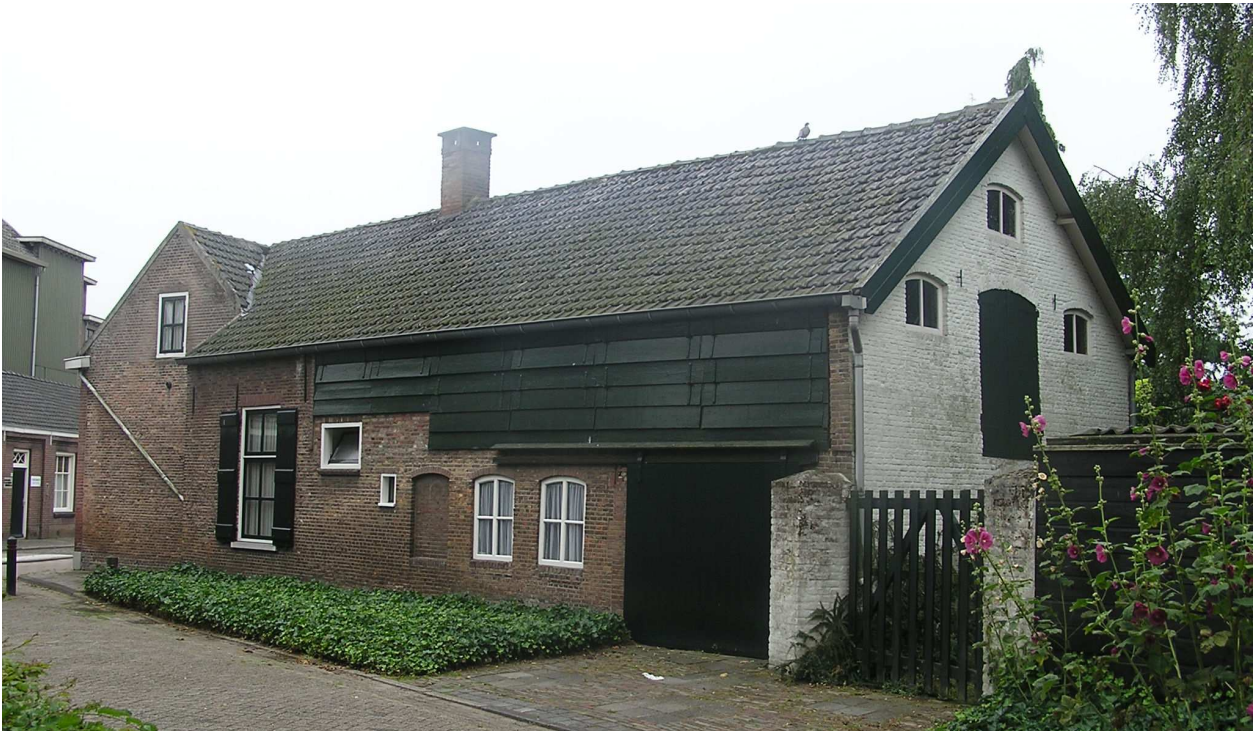
Foto C12 Foto van een schoolvoorbeeld van een huisleerlooierij. In een aanbouw aan de woning bevindt zich het looierijtje, herkenbaar aan de houten ventilatieluiken. (rijksmonument Heuvel 16 te Dongen) (foto Heemkunderkring De Heerlyckheit Dongen)
