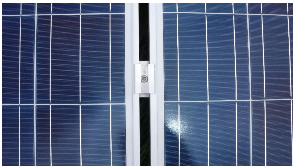
Bovenaanzicht zonnepanelen met centerklem
