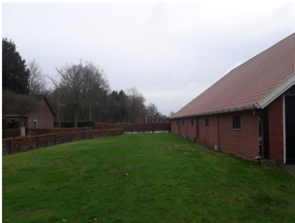
Foto 7: Groenstrook langs de schuur grenzend aan de woonboerderij.
