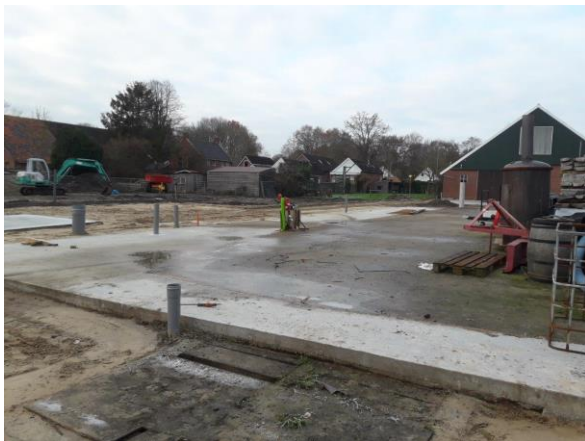
Foto 3: Betonvloer nieuwe schuur met op achtergrond contour voormalige schuur zichtbaar aan het gele zand
