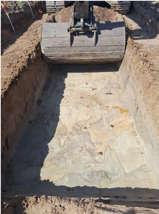
Afbeelding 173. Foto genomen tijdens het verdiepen ter plaatse van de beek. Kijkrichting is richting het noorden. Aan de zuidzijde van de ontgraving is het lemige zand waar te nemen terwijl er nog grof beekzand waarneembaar is aan de noordzijde.
