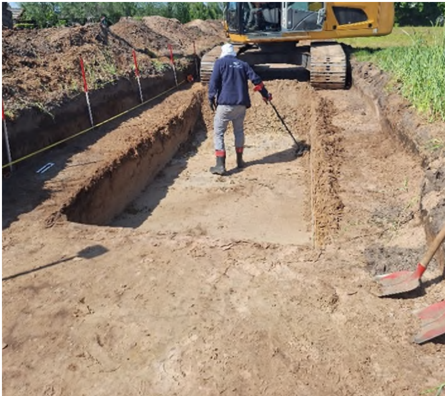
Afbeelding 172. Foto genomen tijdens het verdiepen ter plaatse van de beek. De profielwand kon uiteindelijk niet gedocumenteerd worden door instortingsgevaar. Wel zijn er verschillende licht komvormige zandbanden waargenomen toen bijschaven (rond de tijd van de foto) nog mogelijk was waardoor geconcludeerd kon worden dat dit inderdaad de beek betreft.
