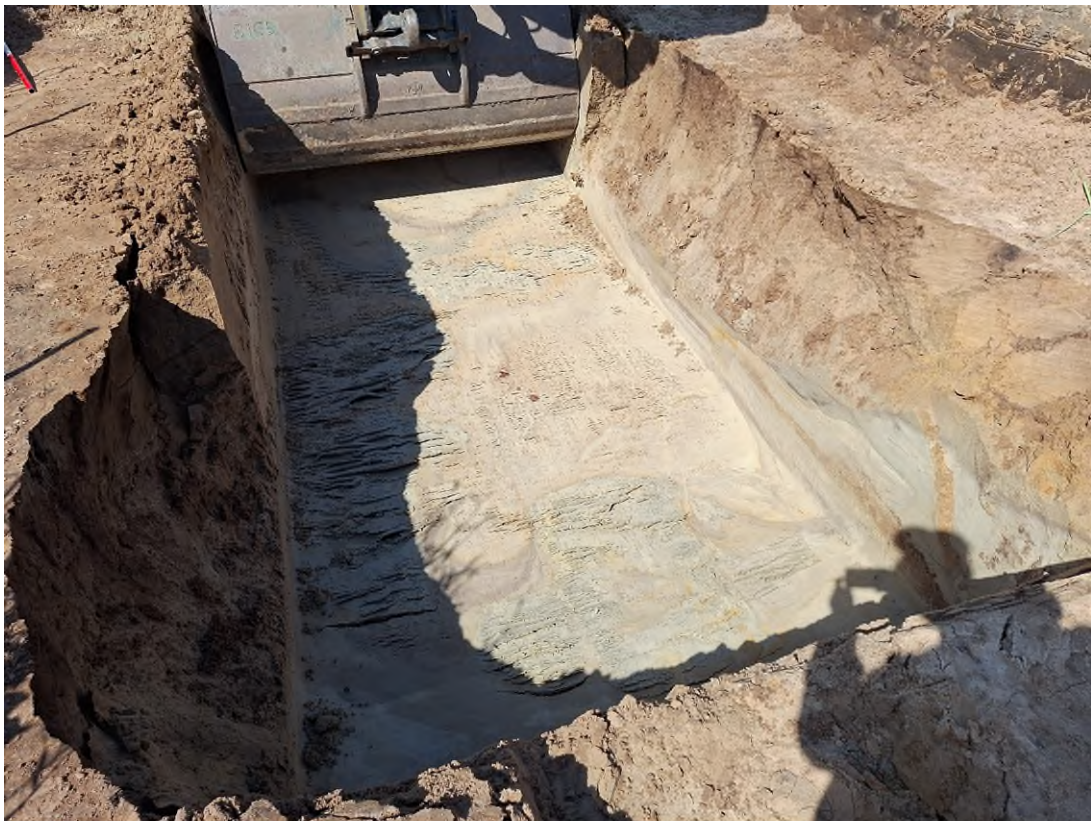
Afbeelding 174. Foto genomen tijdens het verdiepen ter plaatse van de beek. Kijkrichting is richting het noorden. De wanden waren hier zeer onstabiel, maar de onderkant van de beek was nog niet bereikt.
