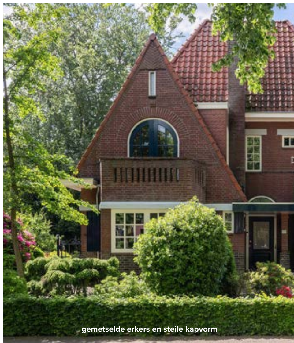
meerdere woningen vormen samen één ensemble (Heuvelstraat 15, Deurne)
