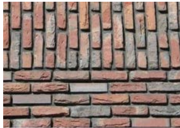
accenten in de gevel
