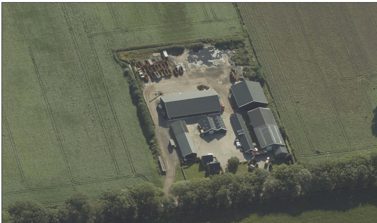
Figuur 3: Bestaande bebouwing (www.cyclomedia.nl)
