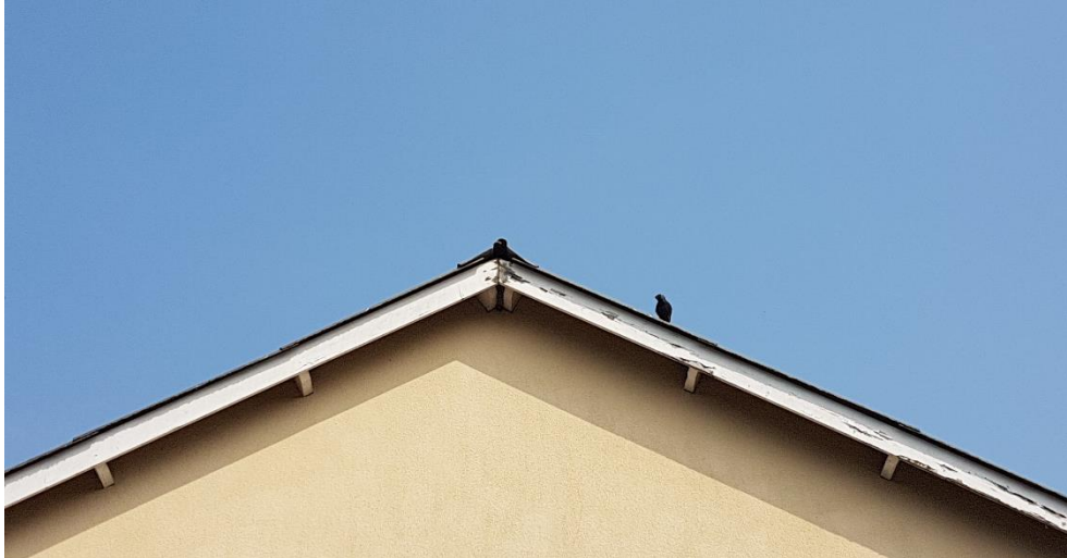
Foto 8. Nest van kauw in de nok van het dak
