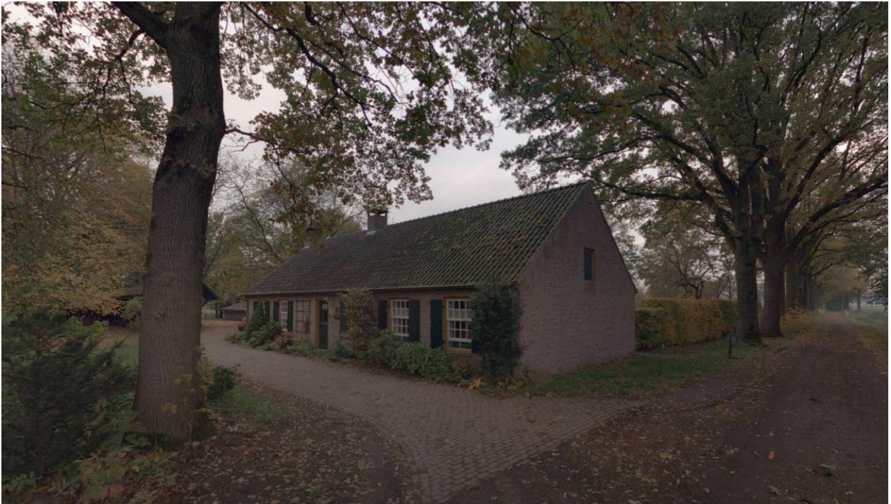
Figuur 2.2.7: Langgevelboerderij Kievitweg 9.
