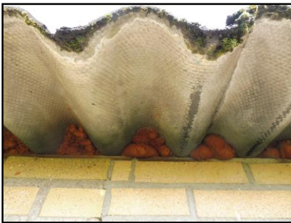
Afgedichte golfplaten dakbedekking en indruk binnenzijde van enkele varkensstallen.
