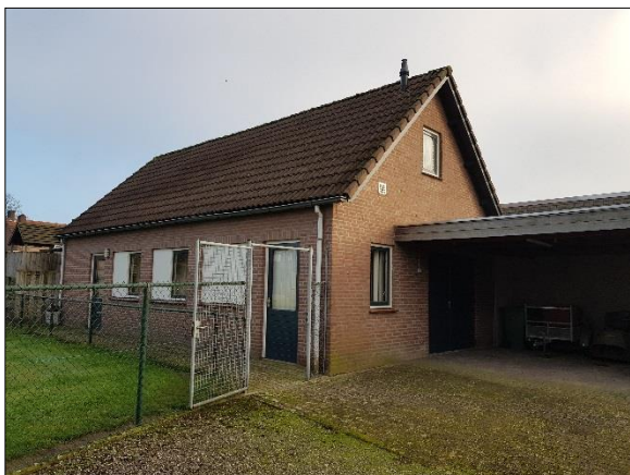
Figuur 6. Te slopen bijgebouw
