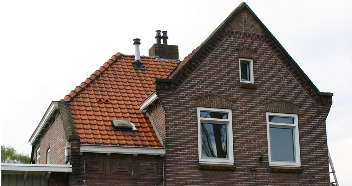
Figuur 12. Voorzijde van het woonhuis. Hier is te zien hoe verschillende gevels hoog opgemetseld zijn.
