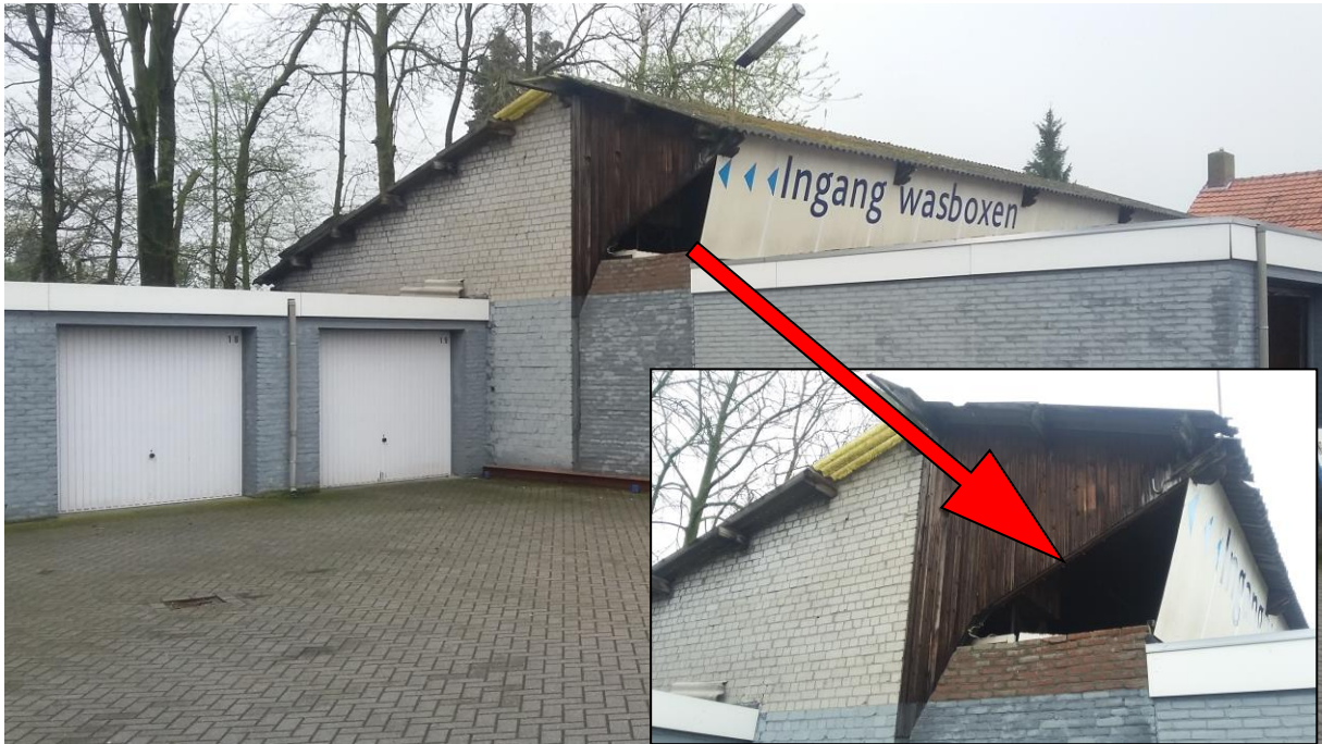
Figuur 14. De oude schuur achter de garageboxen heeft een grote opening aan de zijkant (rode pijl) die uitkomt aan de binnenkant van twee garageboxen.
