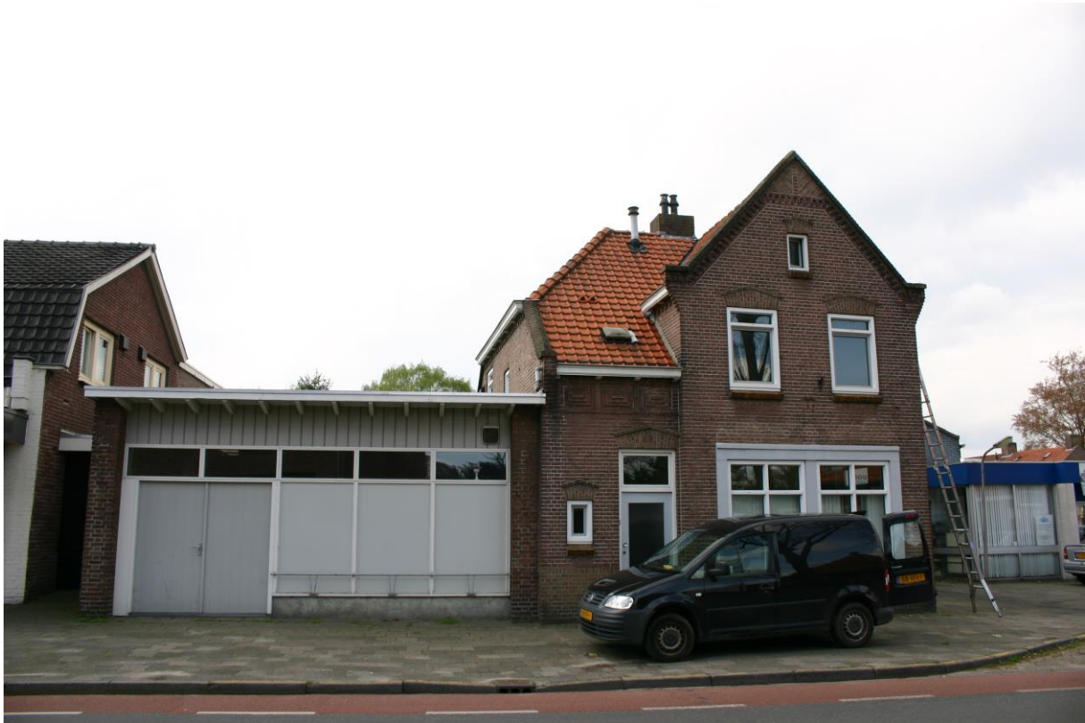
Figuur 6. Woonhuis met aangrenzende garage.
