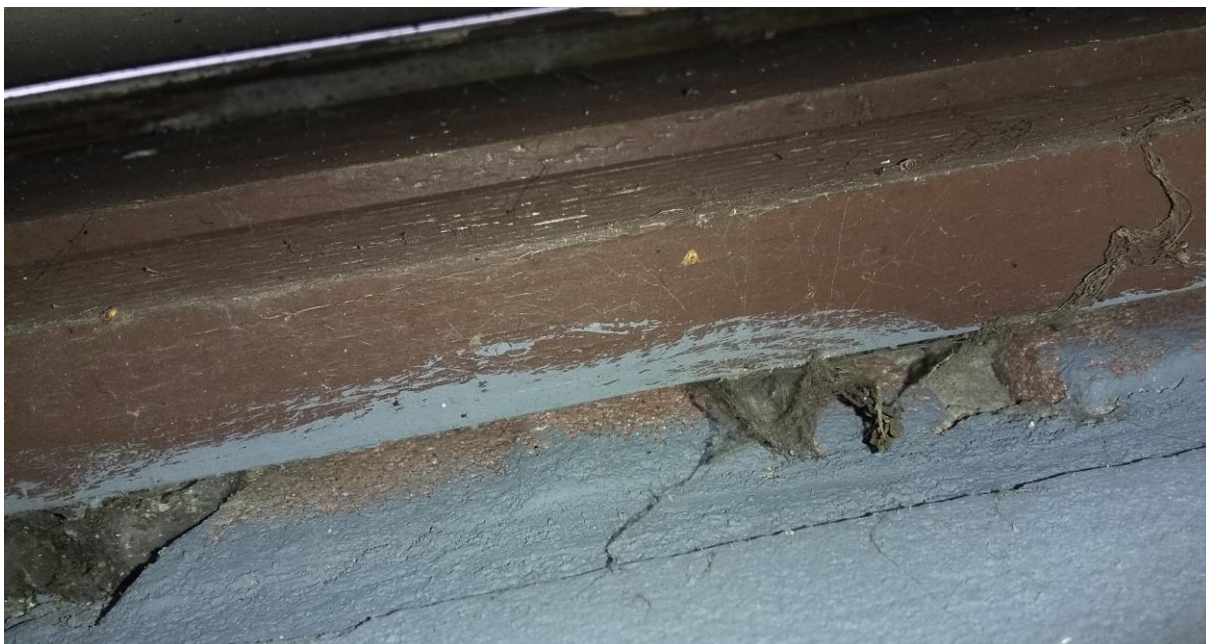
Figuur 15. Onderaanzicht van de kier tussen de muur en boeiboord van de garageboxen en hondentrimsalon.
