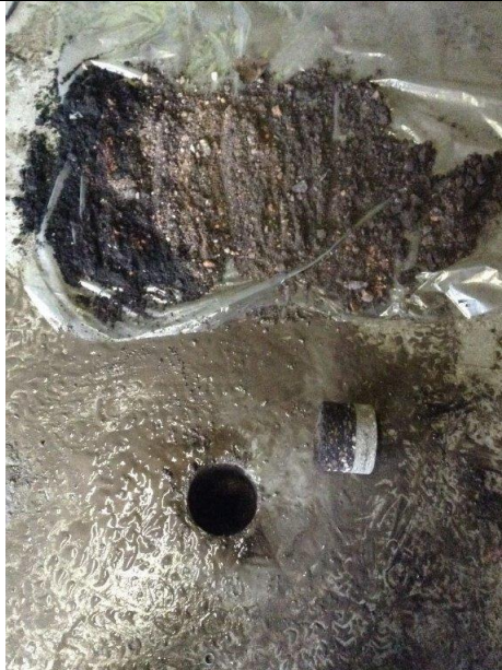
07. Heuvelstraat 5-7 Garage-opslag meetpunt 11a.jpg
