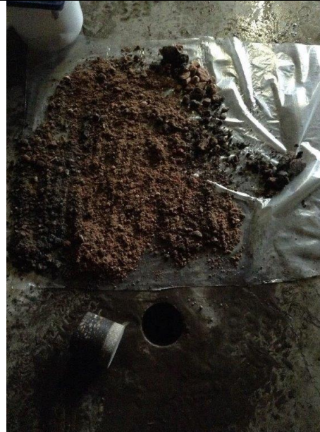
08. Heuvelstraat 5-7 Garage-opslag meetpunt 13a.jpg
