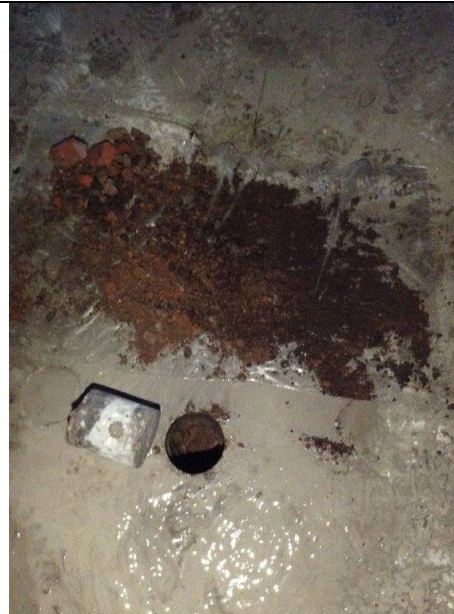
06. Heuvelstraat 5-7 Garage-opslag meetpunt 10a.jpg
