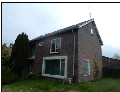
Figuur 2. Woning Derpsestraat 39 binnen contouren van de onderzoekslocatie.
