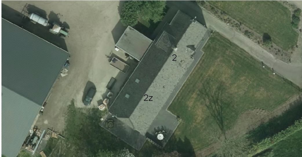
Figuur 5: luchtfoto woning met omliggend terras/verharding
