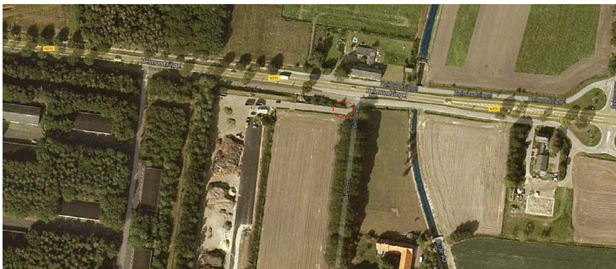
Uitsnede luchtfoto (Bron: www.ruimtelijkeplannen.nl ), met ontsluitingspunt bestaande ontsluiting op parallelweg Helmondsingel rood gemarkeerd
