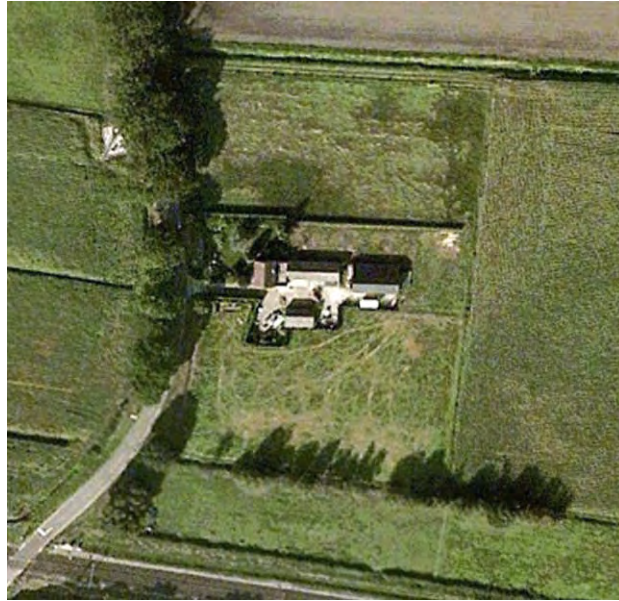
Luchtfoto van de locatie (bron luchtfoto: Google Earth)
