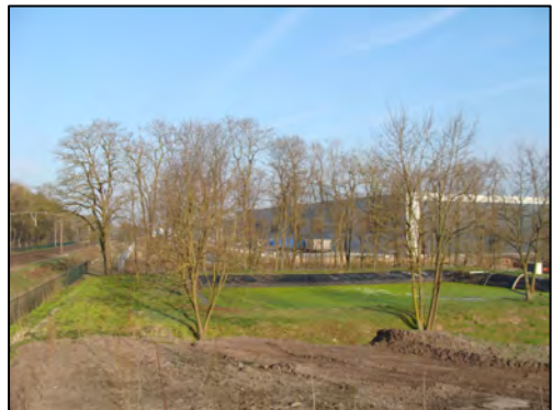
Foto 6. Zuidwest hoek met bassin en reeds ingeplant talud voor natuurcompensatie
