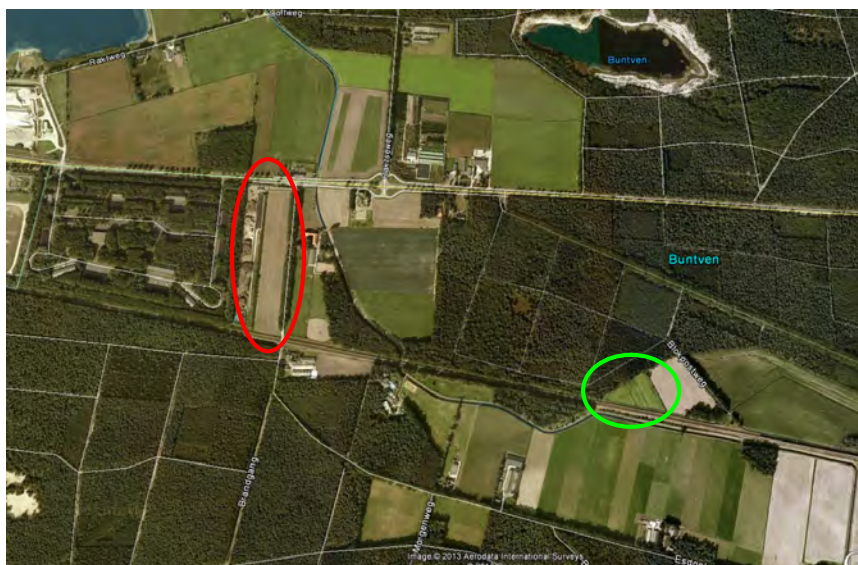
Ligging van het perceel. rood: planlocatie, groen: compensatieperceel (bron luchtfoto: Google Earth)
