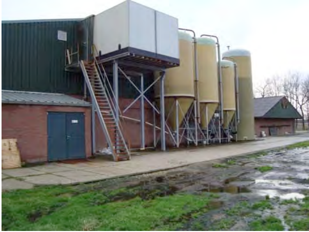
Foto 1. Huidige oostgevel bedrijfsgebouwen.
