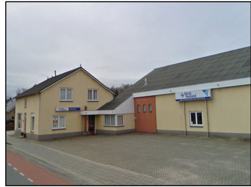
Foto2: te slopen gebouw van Vaccon Peelland.
