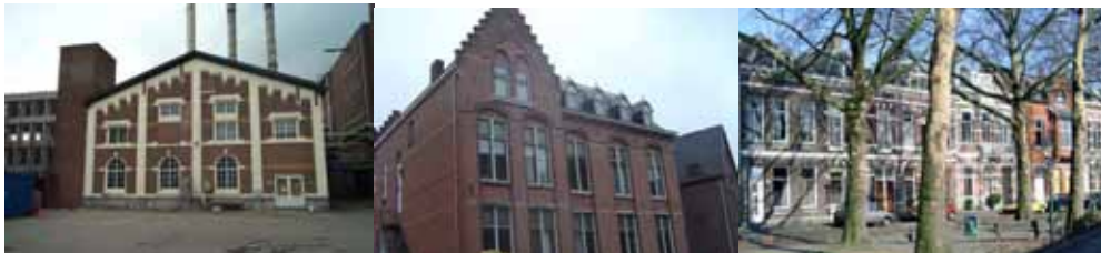
Ketelhuis, Lentehof en woningen aan de Ceresstraat
