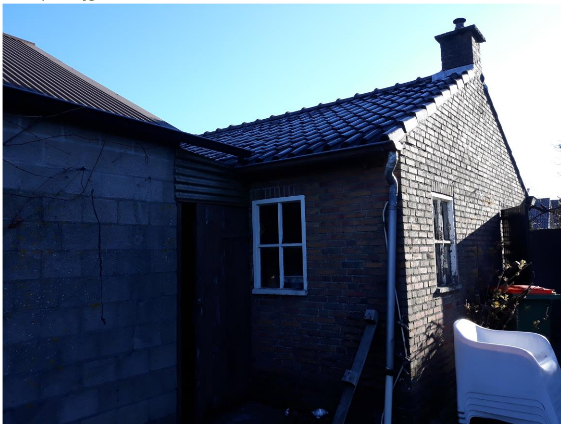
Te slopen bijgebouw:
