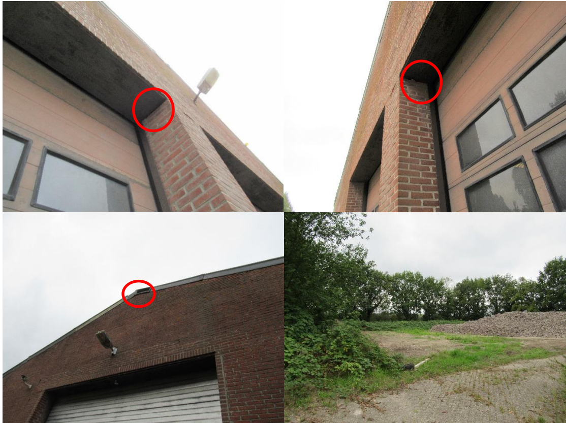
Figuur 4.4. Een voorbeeld van de in de bebouwing aanwezige kieren die als geschikte verblijfplaats kunnen dienen voor vleermuizen. De rode omlijning weergeeft waar de openingen zijn. Rechtsonderin: een indruk van het geschikte foerageergebied.
